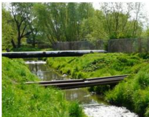
Rycina 5 Istniejące rurociągi przeprowadzane nad rzeką poniżej dopływu rzeki Cerekwianki do rzeki Mlecznej (fot. S. Szklarek)
