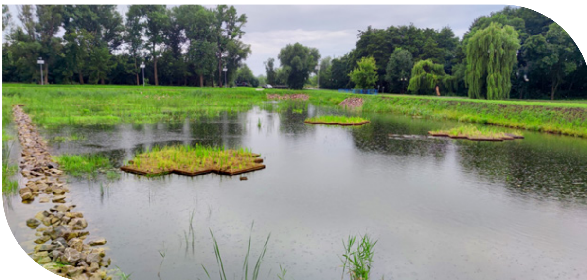
Pływające wyspy dla ptaków na stawach kolmatacyjnych (fot. Wodociągi Miejskie w Radomiu)
