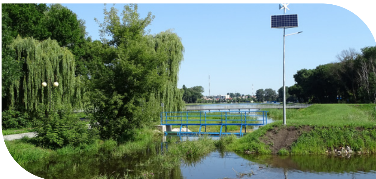
Jaz koźłowy kierujący wody rzeki Mlecznej na zbiorniki kolmatacyjne (fot. Archiwum projektu)
