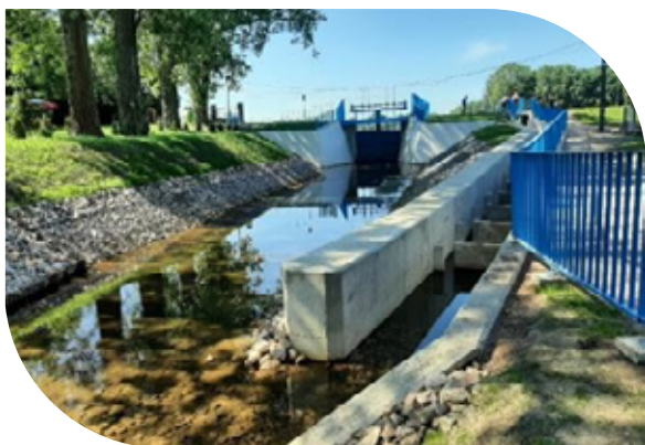
Fot. Przepławka szczelinowa (zdjęcie po lewej) przy jazie (zdjęcie po prawej) na zbiorniku Borki (fot. Z. Kaczowski)
