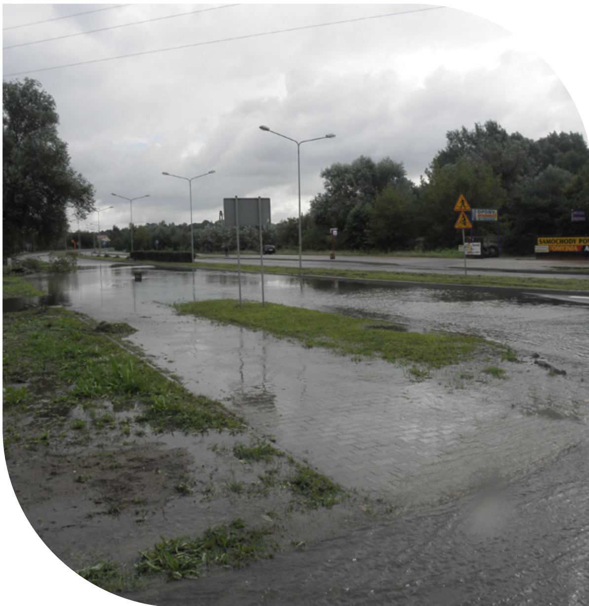
Ulica Maratońska zalana przez Cerekwiankę (fot. Wodociągi Miejskie w Radomiu)
