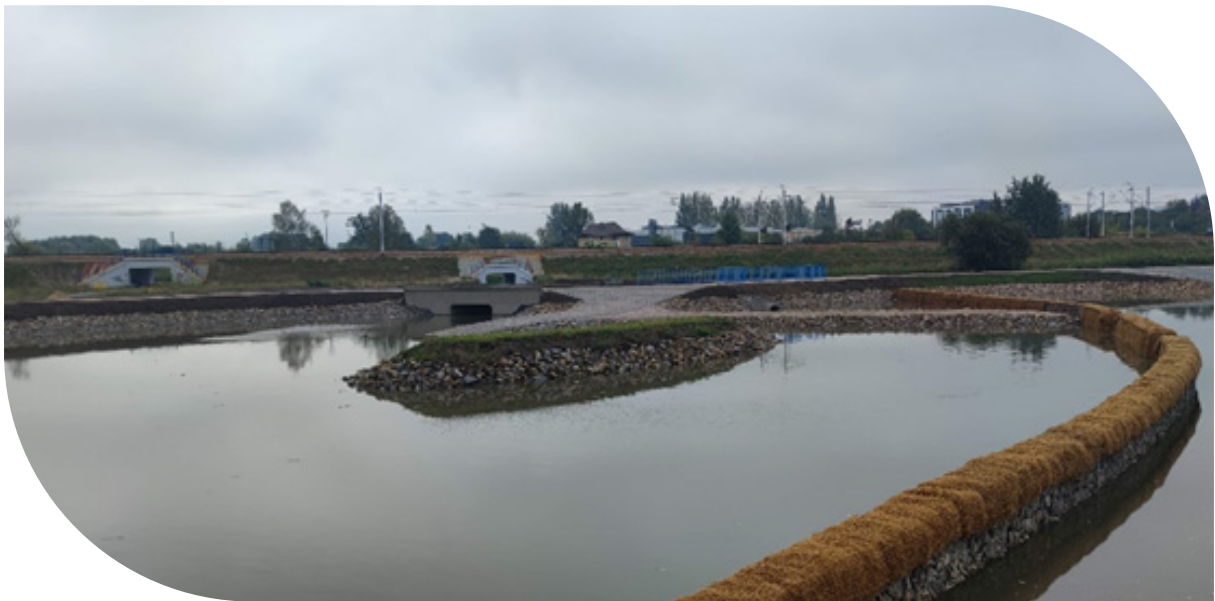
Wielofunkcyjny zbiornik na Potoku północnym przy wysokim stanie wody. Zdjęcie wykonane tuż po ukończeniu prac adaptacyjnych, przed ukonstytuowaniem się roślinności (fot. Wodociągi Miejskie w Radomiu)
