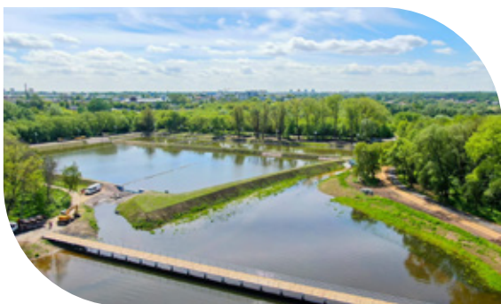
Stawy kolmatacyjne i dopływ rzeki Mleczna do zbiornika Borki (fot. Wodociągi Miejskie w Radomiu, Radomski Dron)
