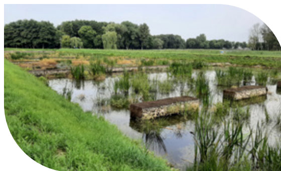
Stawy kolmatacyjne (fot. Archiwum projektu)
