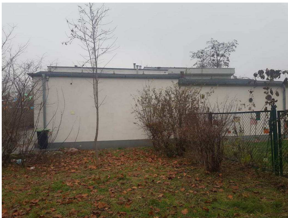
Fotografia 1 Stan terenu przed Wykonaniem robót
