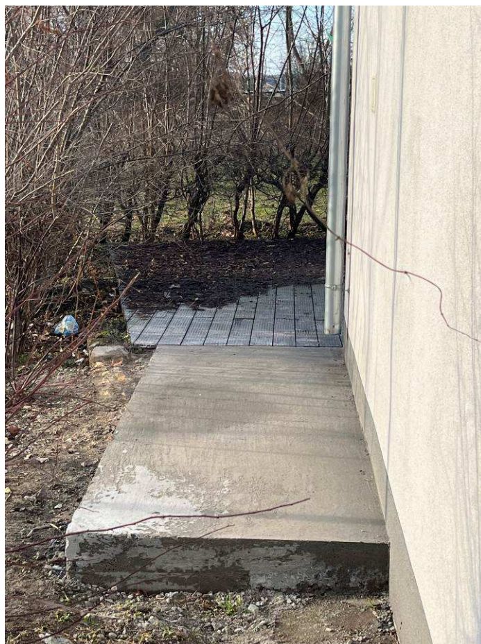
Fotografia 4 Stan terenu w czasie Wykonywania robót – Fundament betonowy
