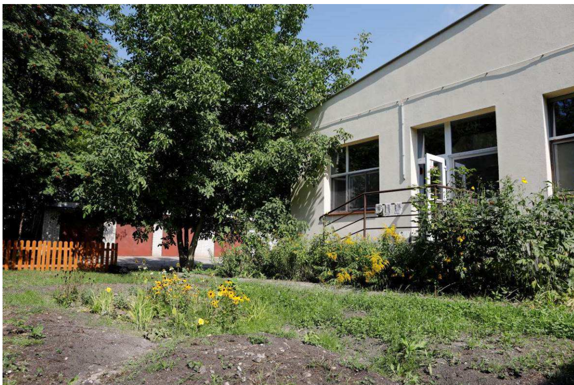
Fotografia 17 Stan terenu po Wykonaniu robót – efekt bioróżnorodności
