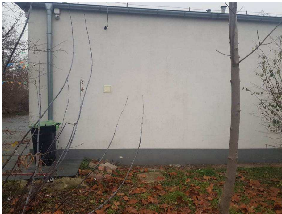
Fotografia 2 Stan terenu przed Wykonaniem robót
