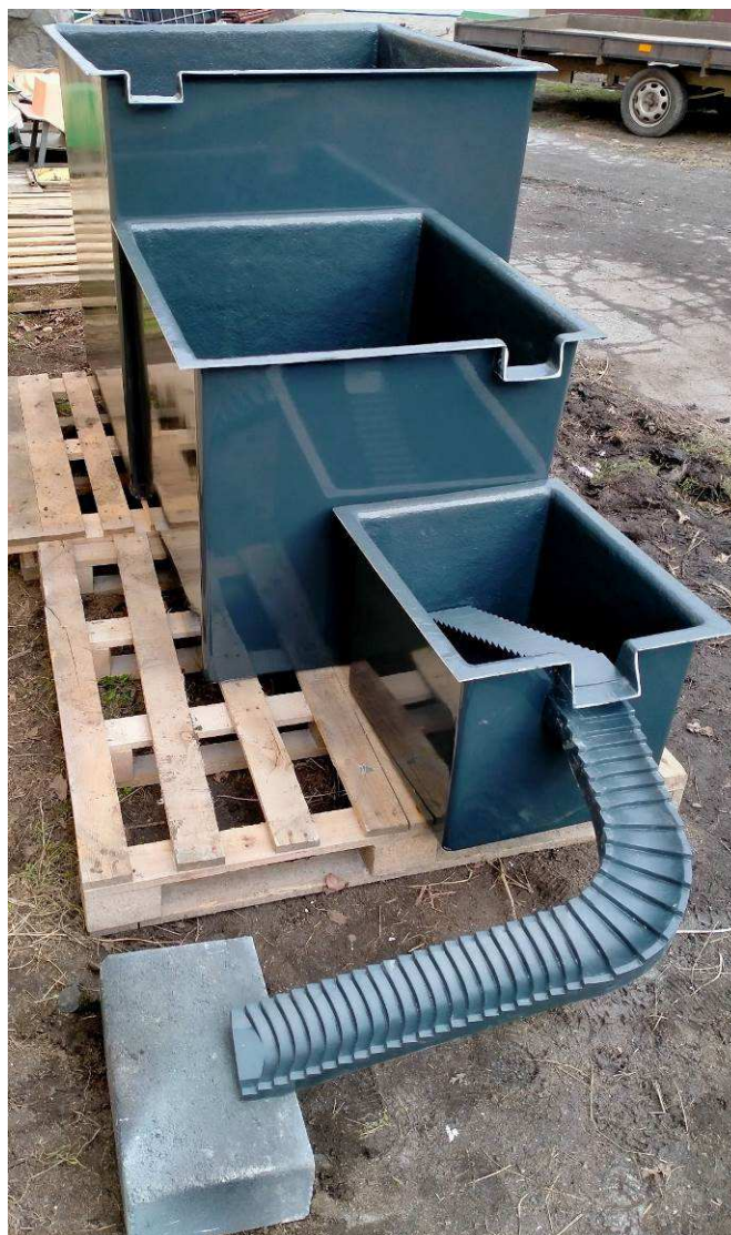
Fotografia 6 Stan terenu w czasie Wykonywania robót – Przygotowanie Climaboxu
