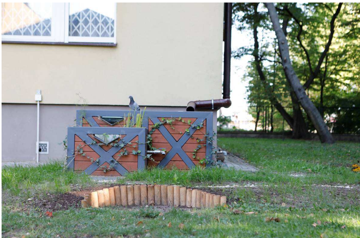
Fotografia 8 Stan terenu po Wykonaniu robót – Climabox + niecka
