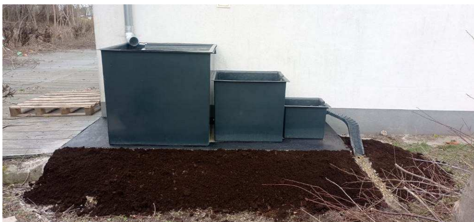
Fotografia 8 Stan terenu po Wykonaniu robót –widok ogólny
