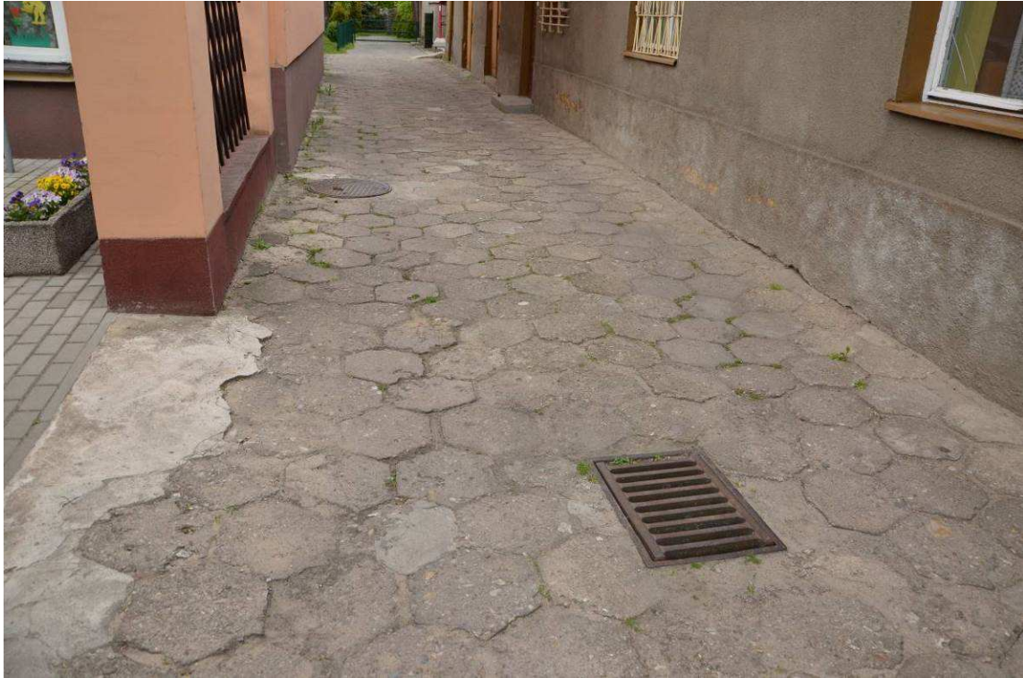
Fotografia 4 Stan terenu przed Wykonaniem robót - Climabox
