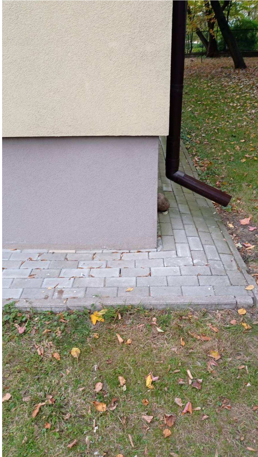
Fotografia 2 Stan terenu przed Wykonaniem robót - Climabox
