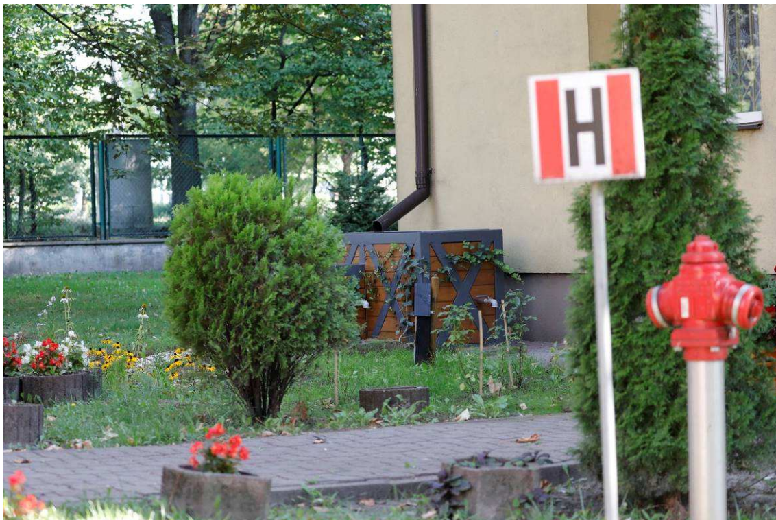
Fotografia 24 Stan terenu po Wykonaniu robót – Climabox + niecka
