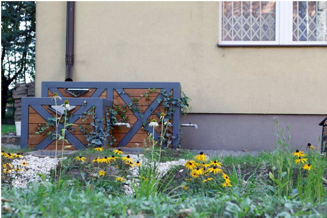
Fotografia 29 Stan terenu po Wykonaniu robót – Climabox + niecka
