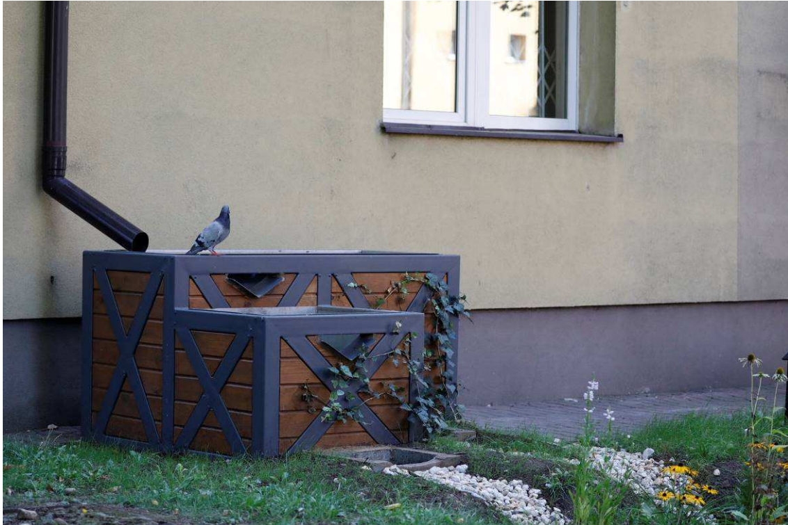
Fotografia 25 Stan terenu po Wykonaniu robót – Climabox + niecka
