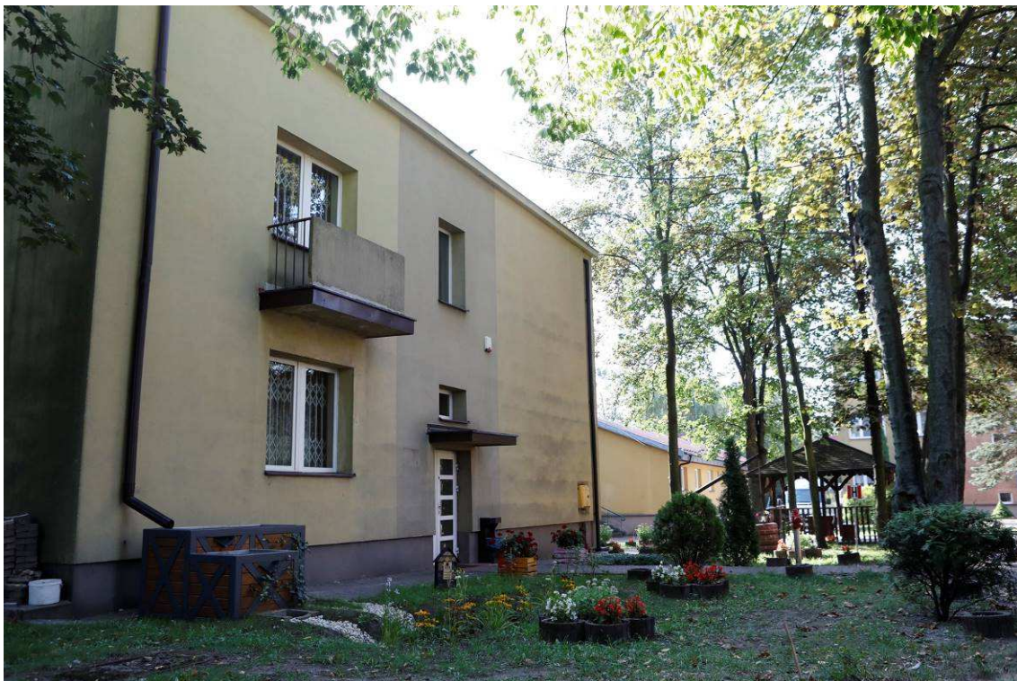
Fotografia 30 Stan terenu po Wykonaniu robót – Climabox + niecka
