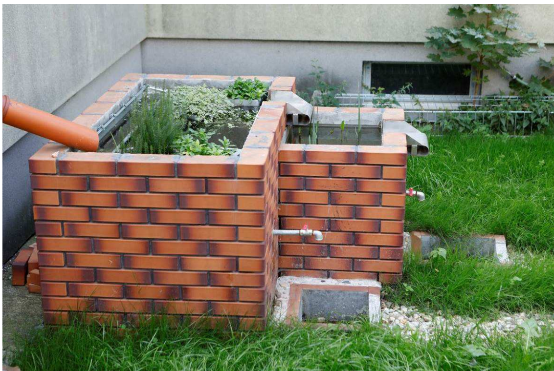
Fotografia 7 Stan terenu po Wykonaniu robót – Climabox
