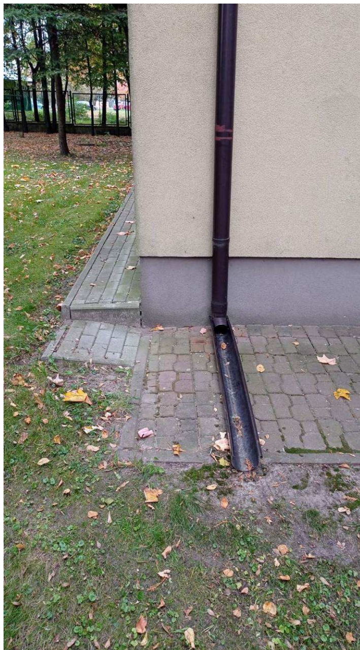
Fotografia 1 Stan terenu przed Wykonaniem robót - Climabox
