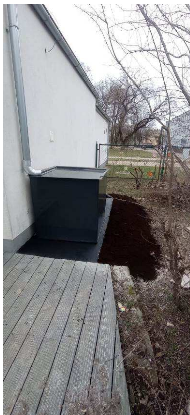
Fotografia 12 Stan terenu po Wykonaniu robót –widok ogólny
