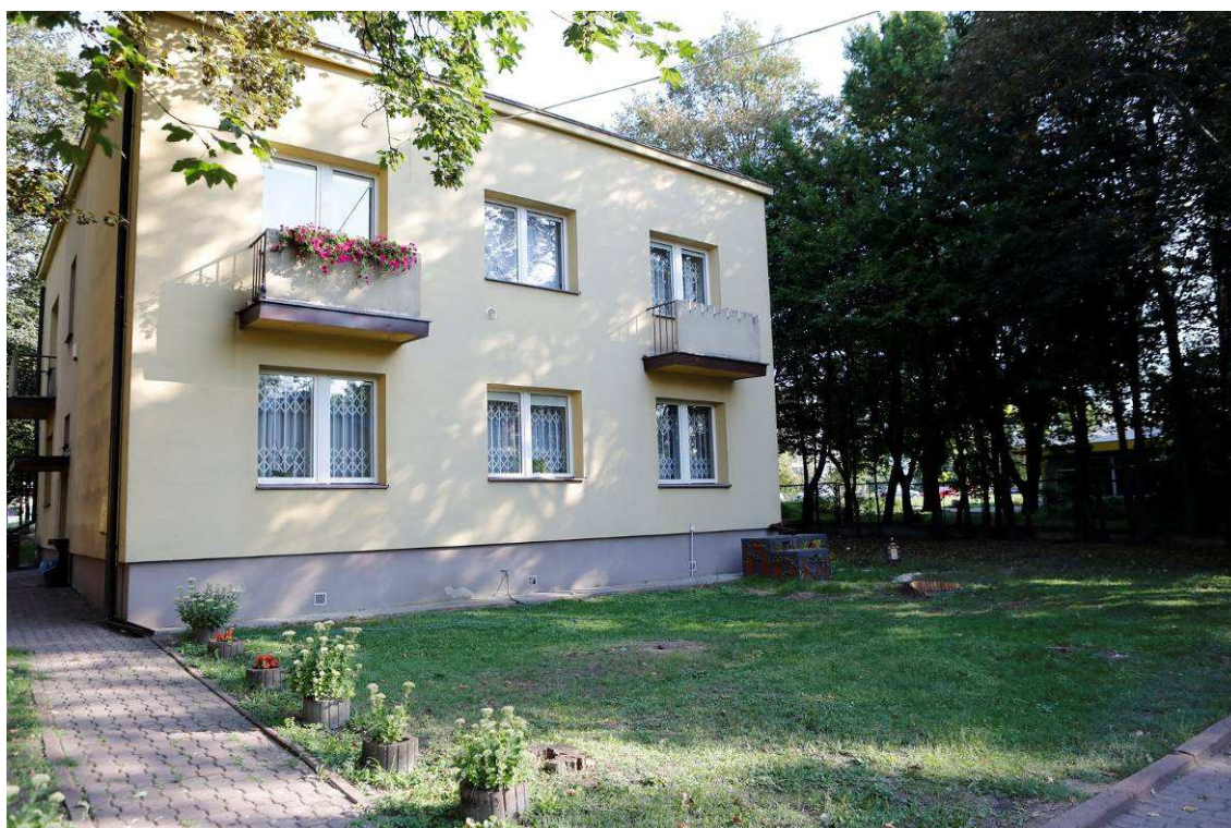
Fotografia 14 Stan terenu po Wykonaniu robót – Climabox
