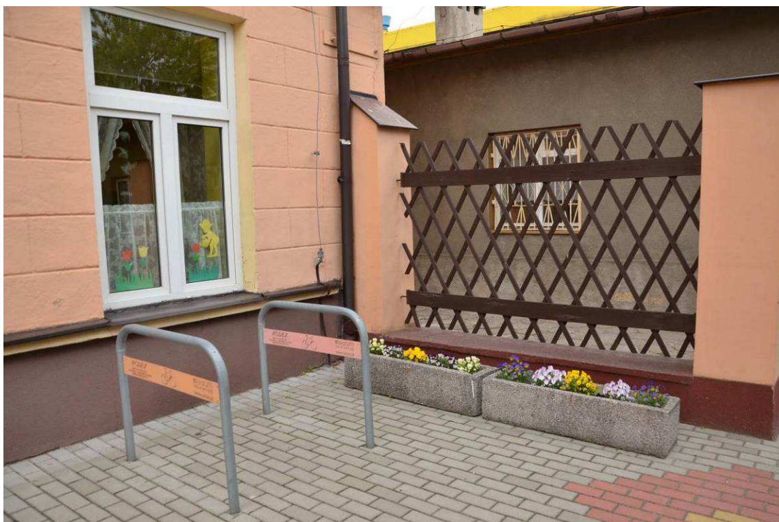
Fotografia 1 Stan terenu przed Wykonaniem robót - Climabox
