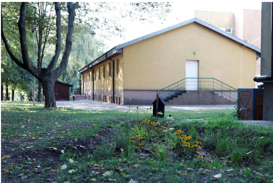
Fotografia 11 Stan terenu po Wykonaniu robót – efekt bioróżnorodności
