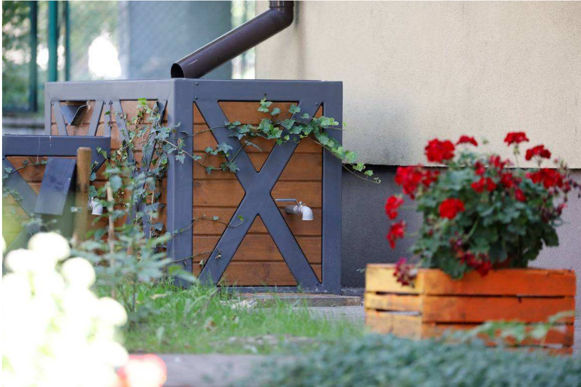
Fotografia 23 Stan terenu po Wykonaniu robót – Climabox + niecka
