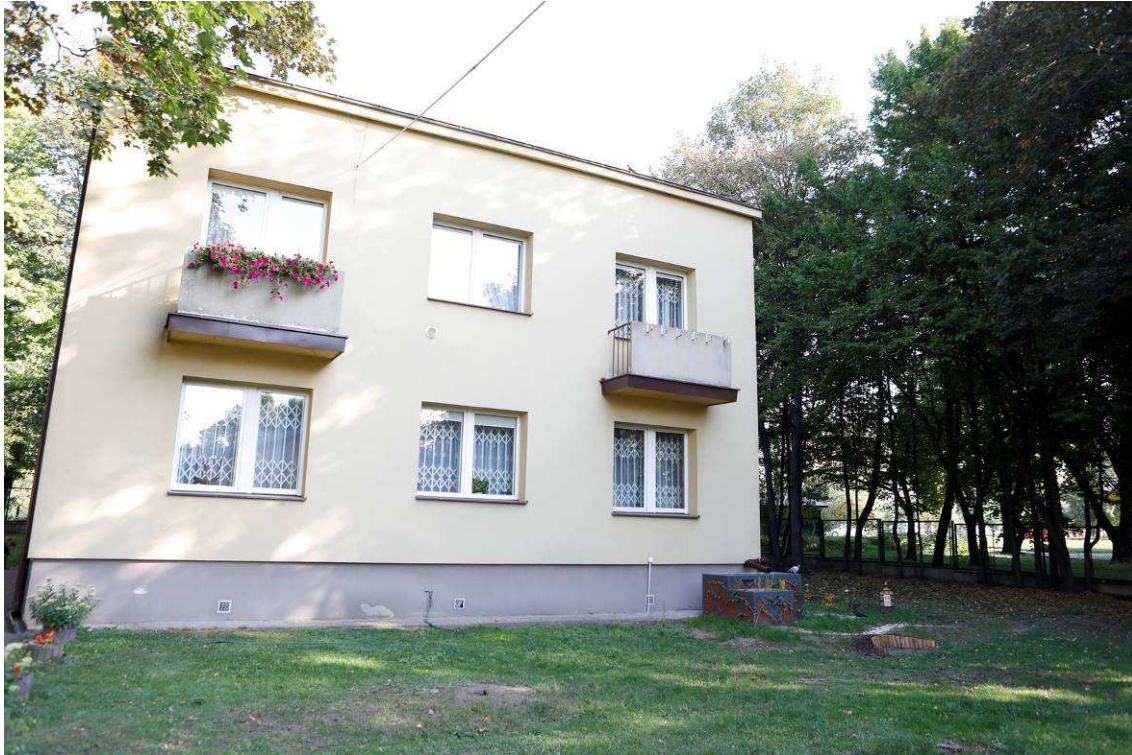
Fotografia 3 Stan terenu po Wykonaniu robót – Climabox + niecka
