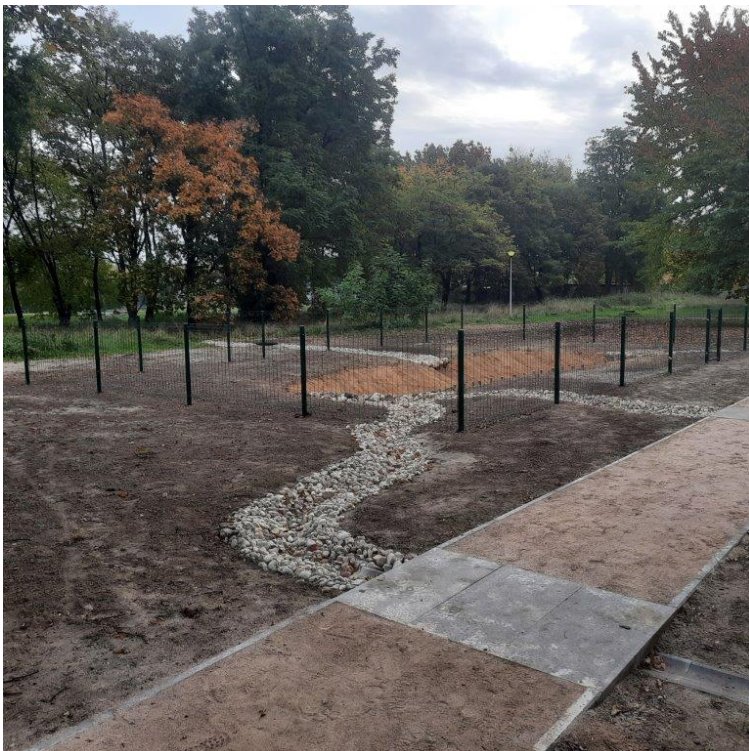
Rysunek 8 Wygląd terenu po zakończeniu prac – Climapond, suche strumienie i przepust pod chodnikiem – powierzchnia przepuszczalna
