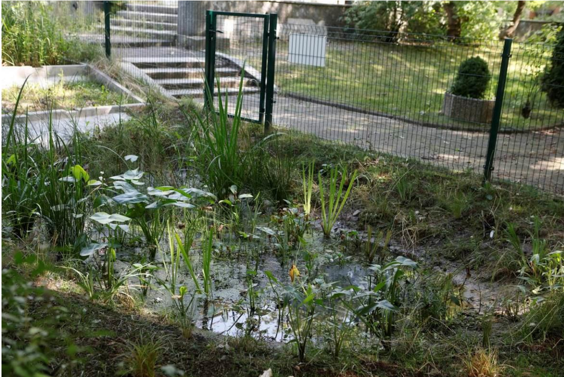
Zdjęcie5 Wygląd terenu po wybudowaniu – Climapond
