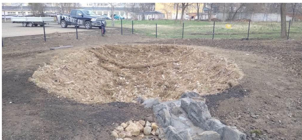
Zdjęcie 11 Wygląd terenu po zakończeniu prac -Climapond z elementem rozpraszającym wodę wykonanym z tworzywa sztucznego imitującego kamień naturalny; Zbocza stawu klimatycznego wyłożone matą kokosową do utrzymania roślinności wodnej
