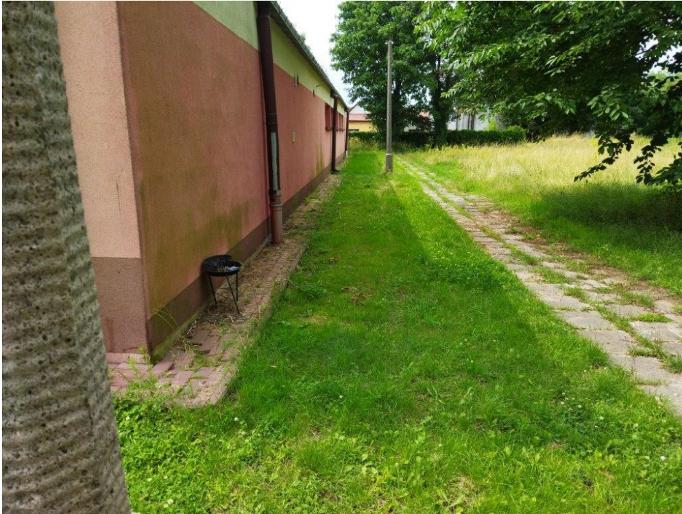
Zdjęcie 1 Wygląd miejsca przed budową - Climapond
