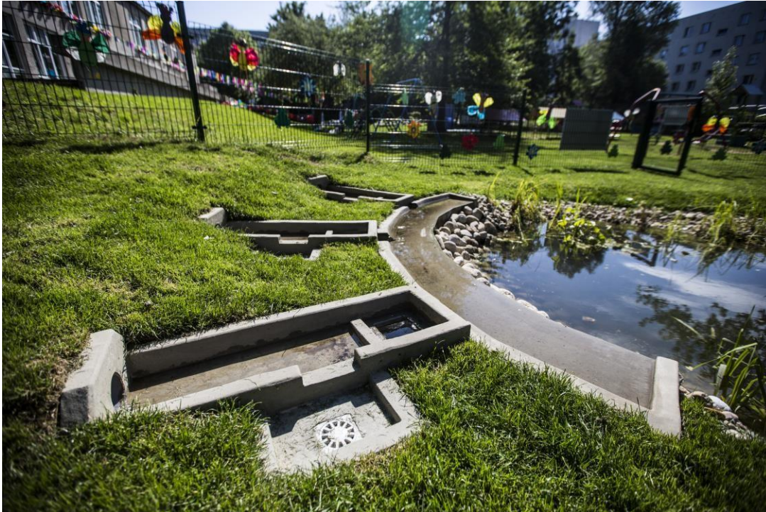
Zdjęcie 11 Wygląd miejsca po zakończeniu prac - Climapond
