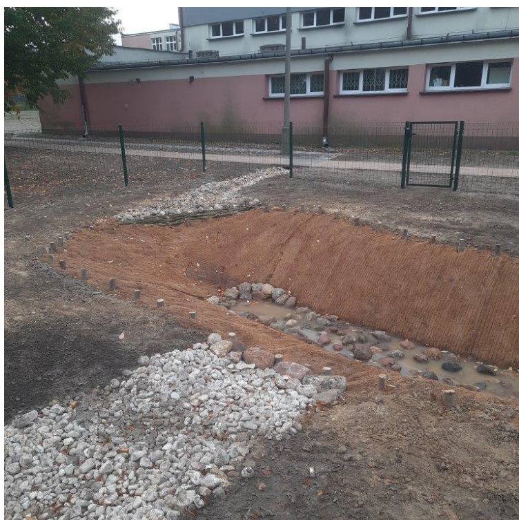
Zdjęcie 10 Wygląd terenu po zakończeniu budowy – Climapond
