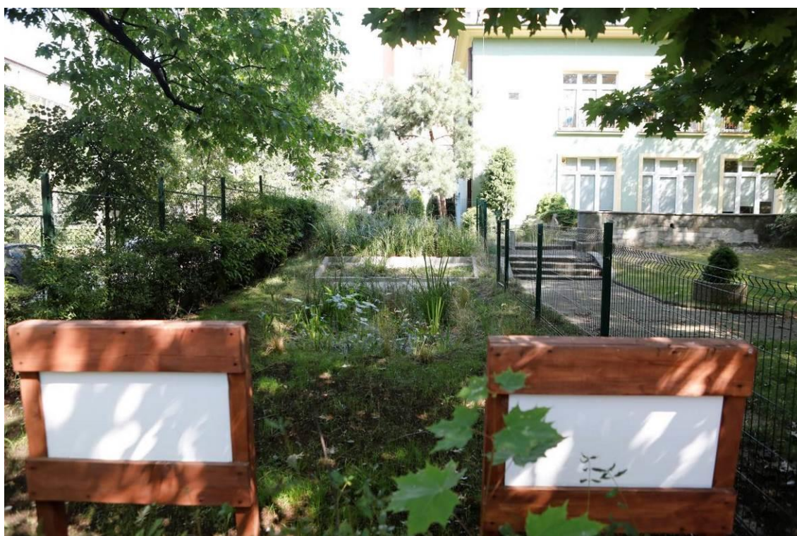
Zdjęcie 9 Teren po budowie – Climapond + tablice informacyjne
