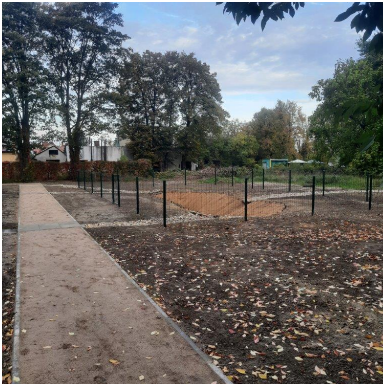
Rysunek 11 Wygląd terenu po zakończeniu budowy – Climapond
