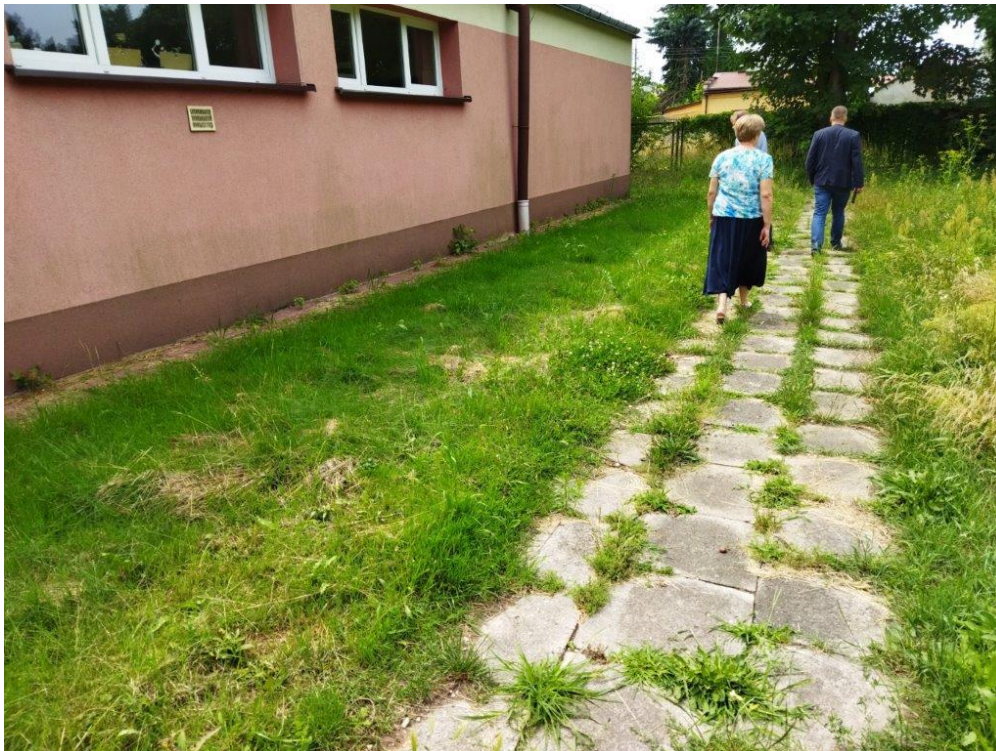
Zdjęcie 3 Wygląd miejsca przed budową - Climapond
