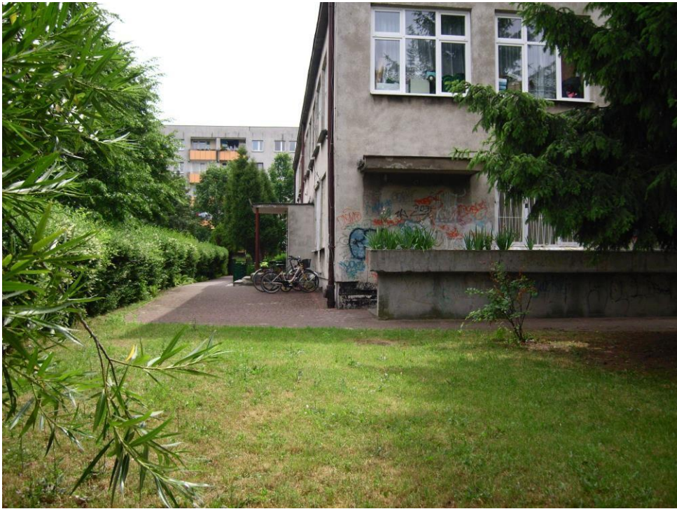
Zdjęcie 1 Wygląd miejsca przed budową - Climapond
