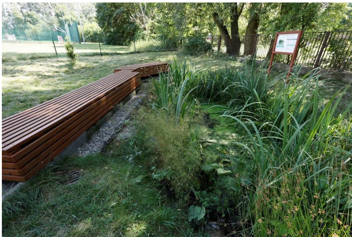
Zdjęcie 16 Wygląd terenu po budowie - Climapond z ławką
