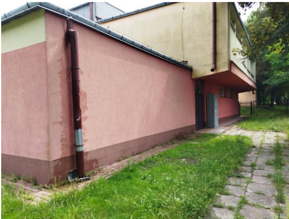
Zdjęcie 4 Wygląd terenu przed budową - Climapond
