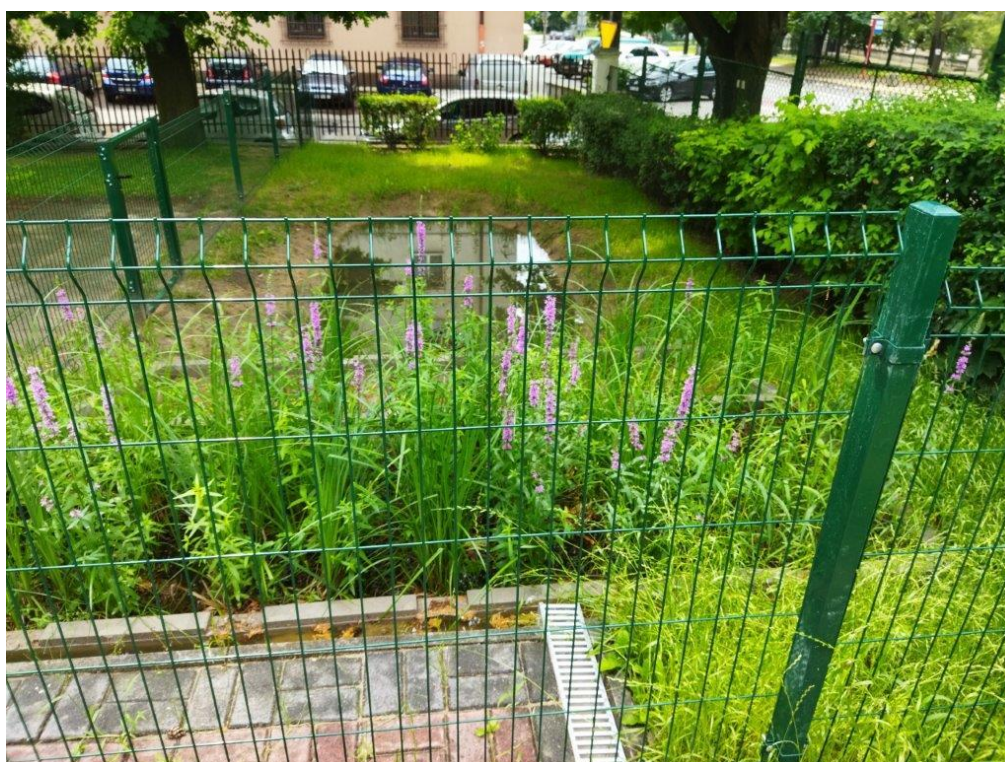
Zdjęcie10 Wygląd terenu po budowie – Climapond + ogrodzenie
