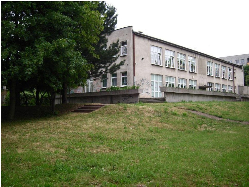
Zdjęcie 2 Wygląd miejsca przed budową - Climapond
