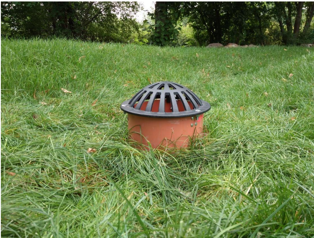
Zdjęcie 12 Wygląd terenu po zakończeniu prac -awaryjny przelew do kanalizacji - Climapond
