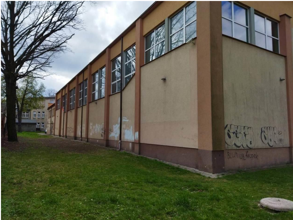
Zdjęcie 4 Wygląd terenu przed budową – Climapond
