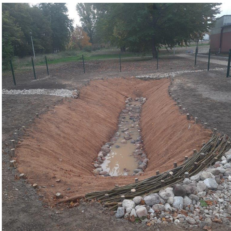
Zdjęcie 9 Wygląd terenu po budowie – Climapond - element dyspergujący w postaci kamiennej zapory z podporą faszynową
