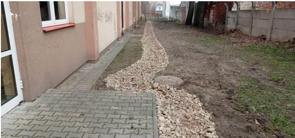
Zdjęcie 8 Wygląd terenu po zakończeniu prac - suche strumienie zbierające wodę z rur spustowych i kierujące ją do Climpondu
