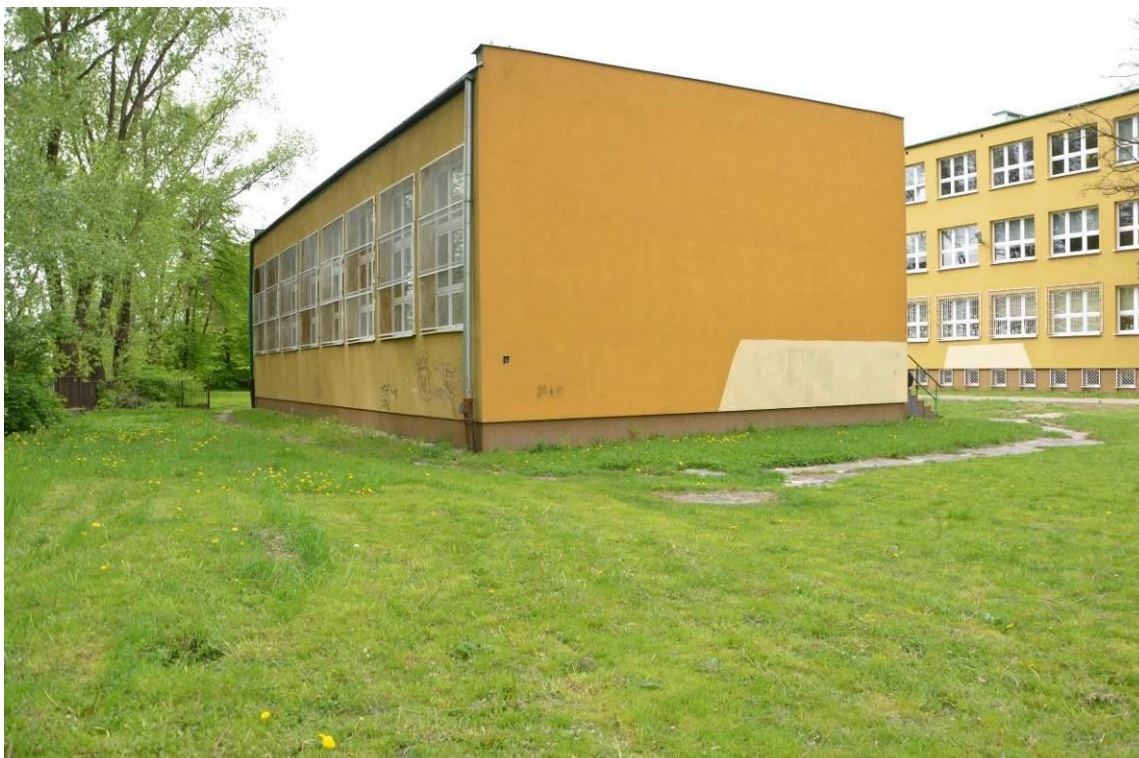
Zdjęcie 1 Wygląd terenu przed budową - Climapond z ławką
