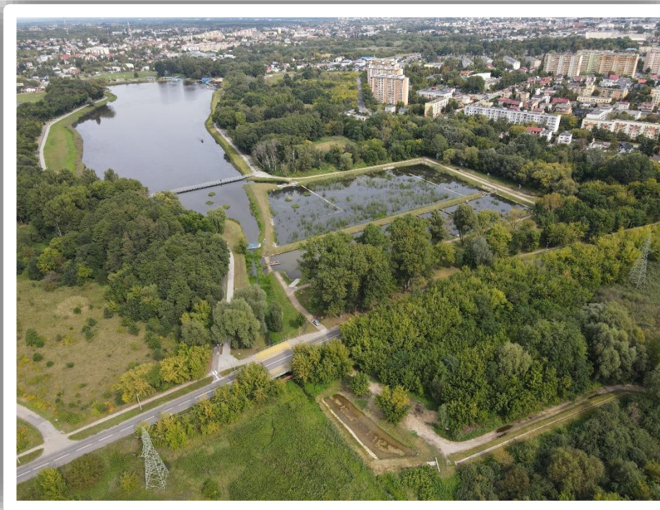
Zdjęcie 1 (źródło: S. Szklarek UŁ) Zbiornik Borki, stawy kolmatacyjne i kanał A0.
