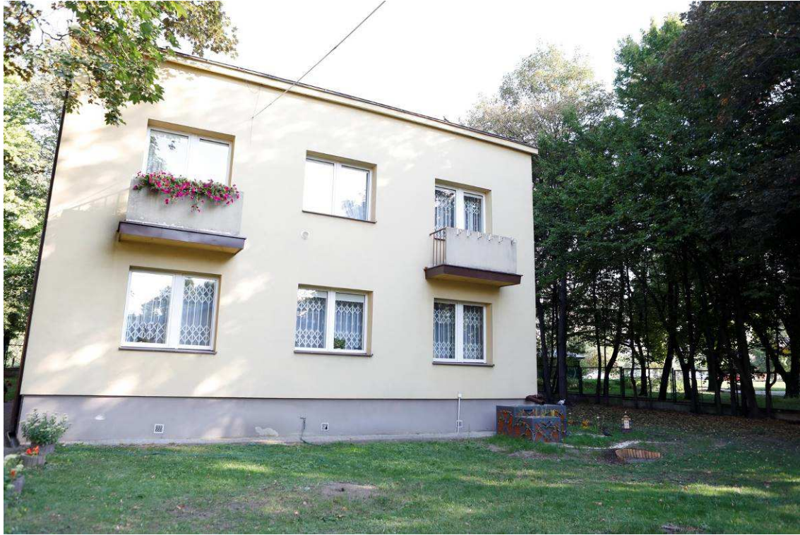
Zdjęcie 43 Stan terenu po Wykonaniu robót - Niecka chłonna
