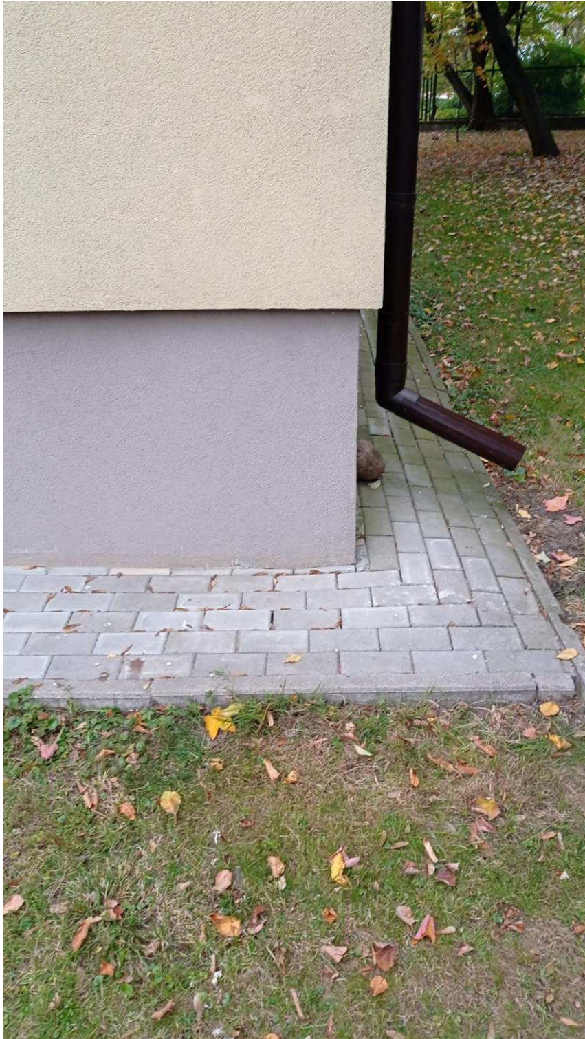
Zdjęcie 42 Stan terenu przed wykonaniem robót - Niecka chłonna
