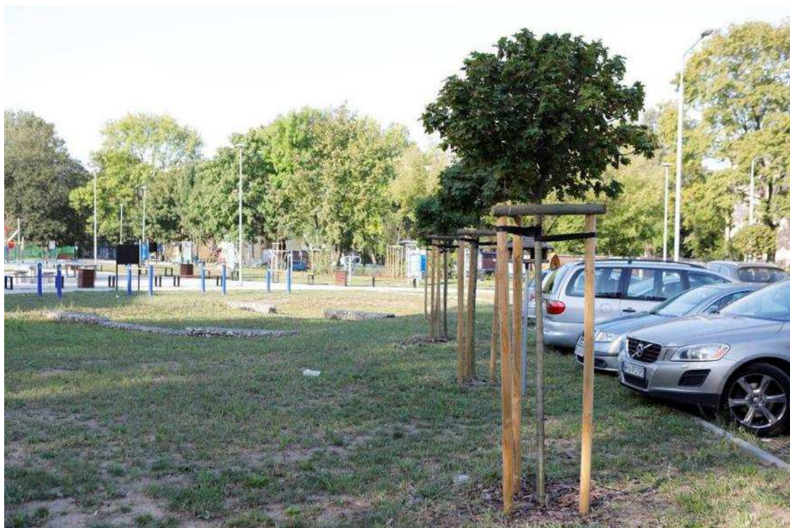
Zdjęcie 17 Stan terenu po Wykonaniu robót - Niecki chłonne - nasadzenia drzew
