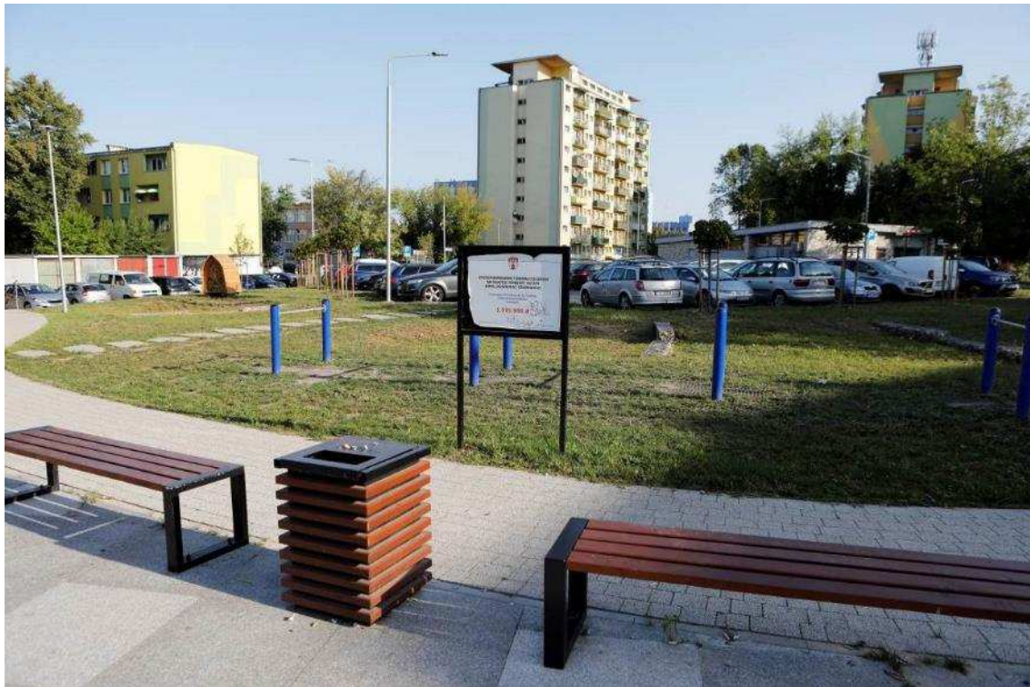
Zdjęcie 11 Stan terenu po Wykonaniu robót - Niecki chłonne -elementy małej architektury
