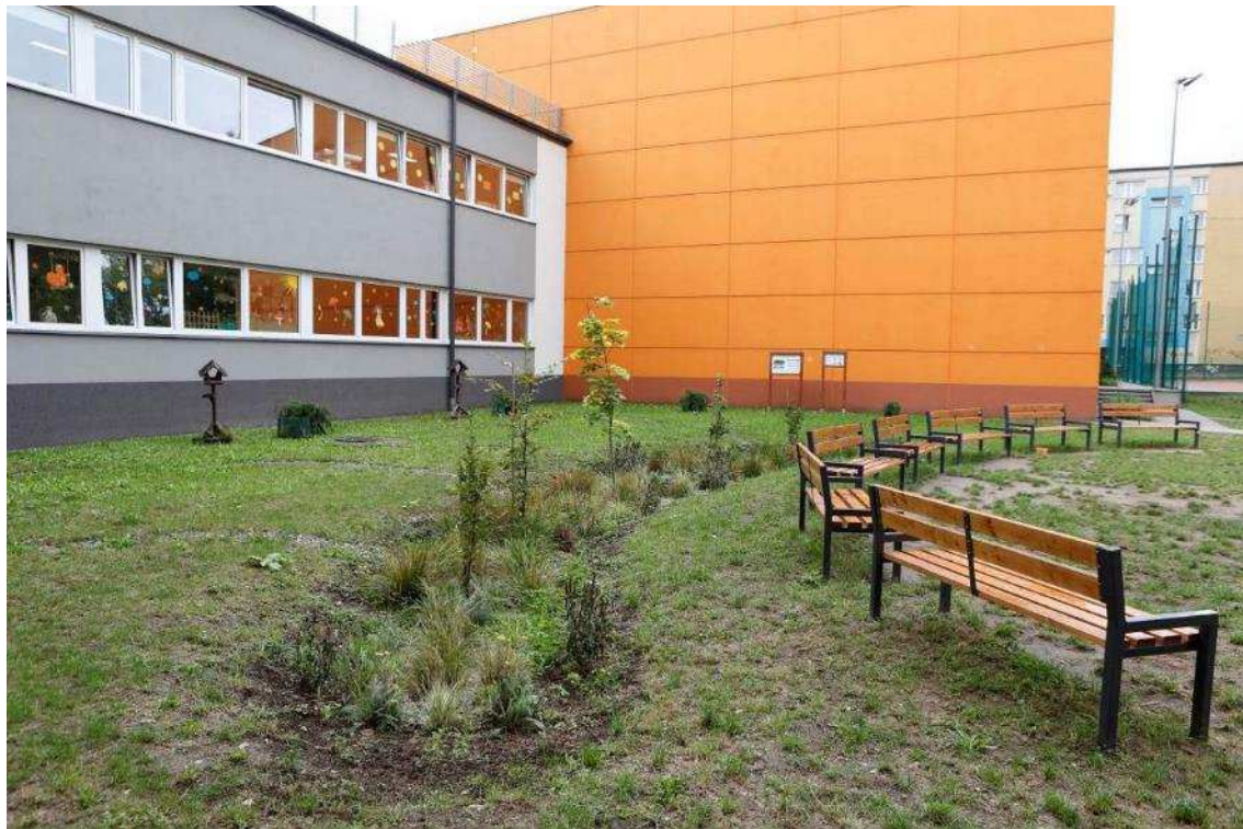
Zdjęcie 6 Stan terenu po Wykonaniu robót - Niecka chłonna ze szpalerem drzew + elementy małej architektury
