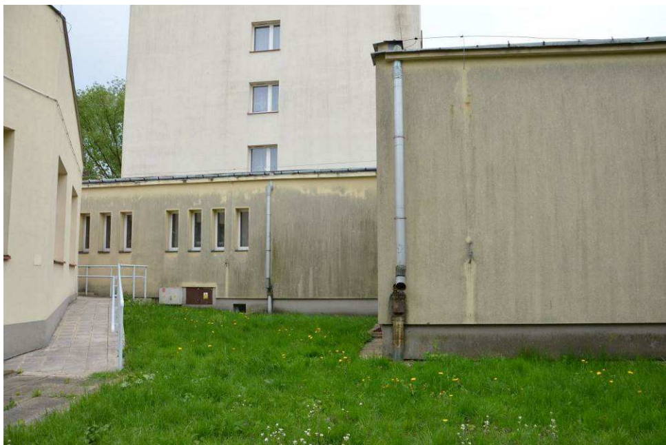
Zdjęcie 37 Stan terenu przed wykonaniem robót - Niecka chłonna
