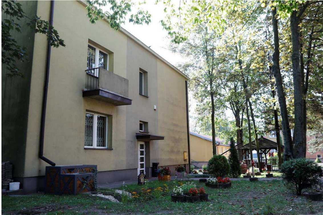
Zdjęcie 23 Stan terenu po Wykonaniu robót - Climabox + niecka
