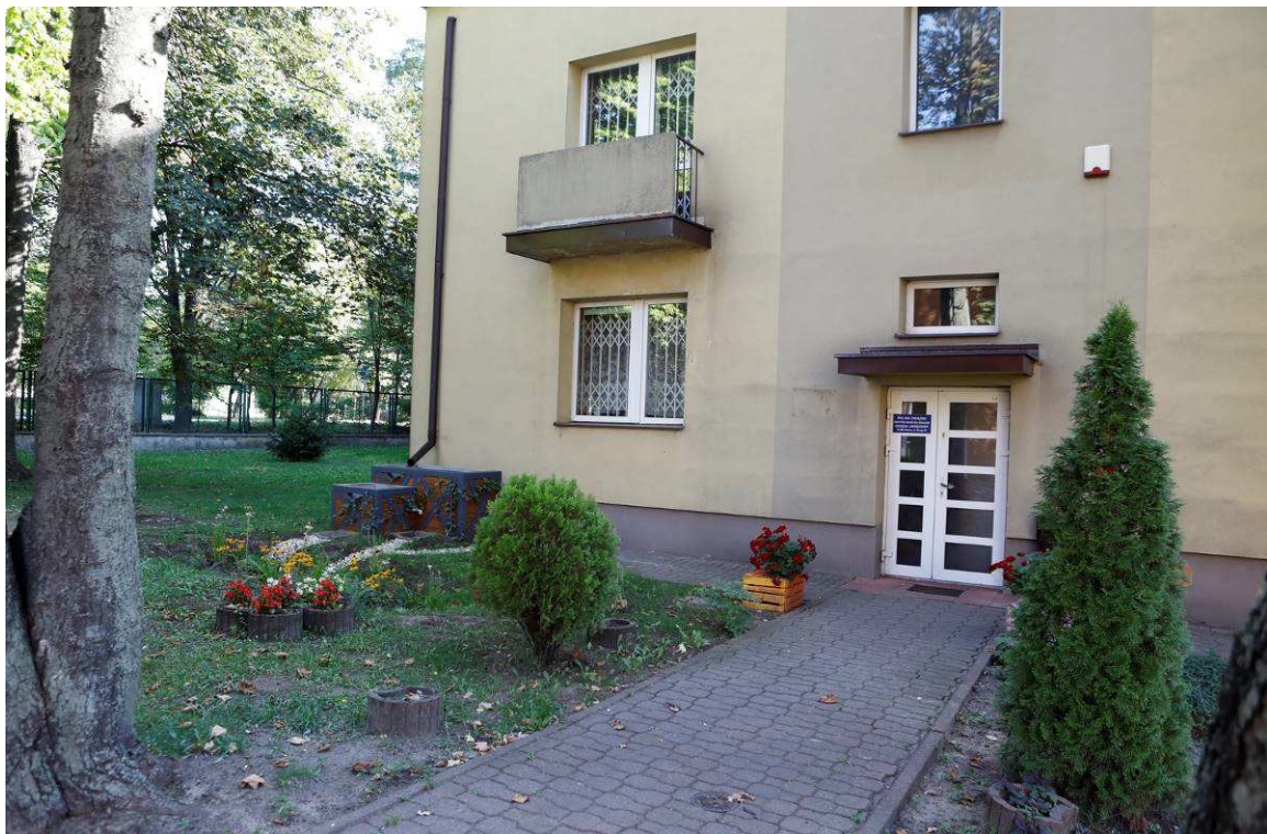
Zdjęcie 20 Stan terenu po Wykonaniu robót - Niecka chłonna
