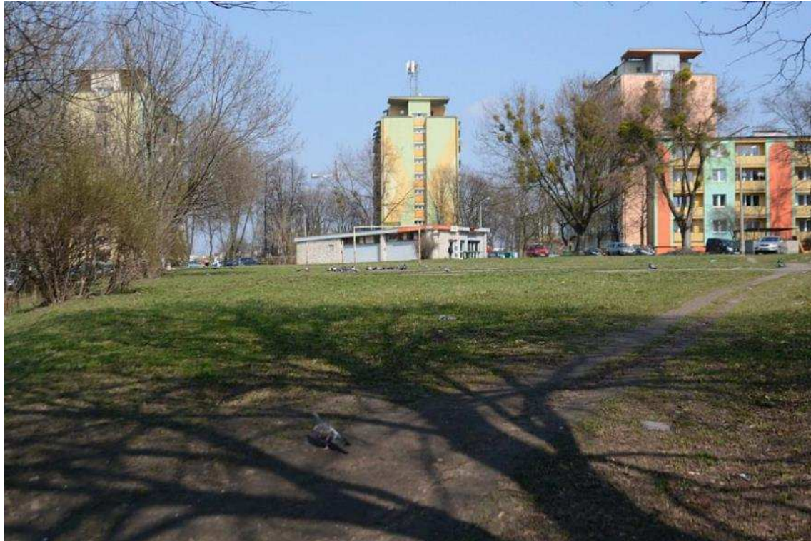
Zdjęcie 1 Stan terenu przed wykonaniem robót
