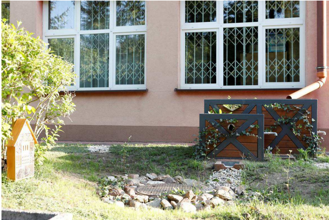
Zdjęcie 9 Stan terenu po Wykonaniu robót - Climabox + niecka
