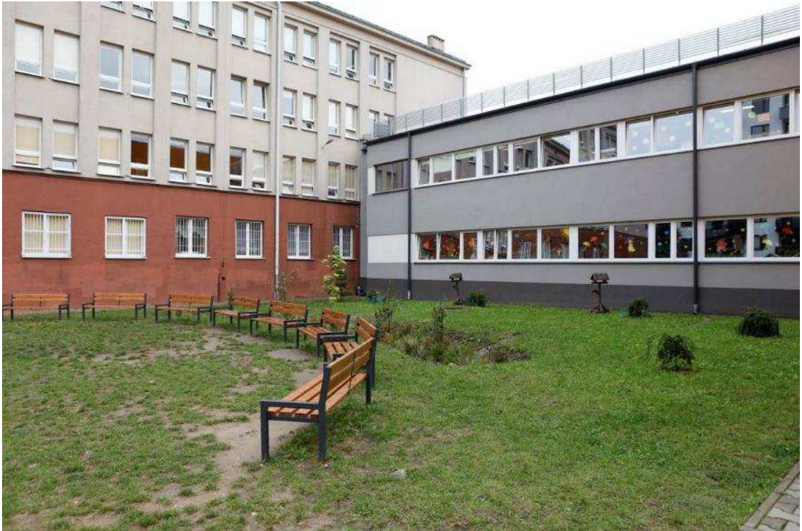
Zdjęcie 5 Stan terenu po Wykonaniu robót - Niecka chłonna ze szpalerem drzew + elementy małej architektury
