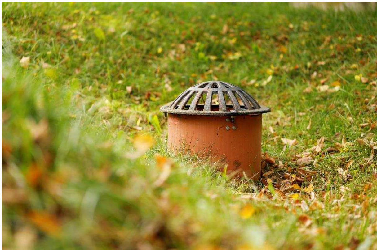
Zdjęcie 2 Wygląd miejsca po zakończeniu prac - Przelew awaryjny po środku niecki
