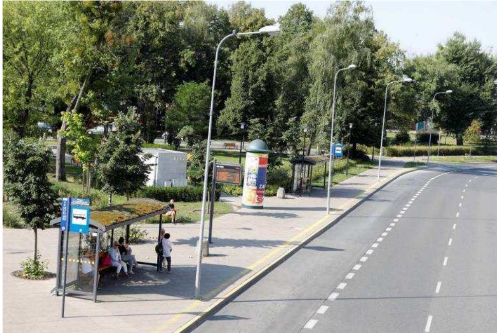
Zdjęcie 5 Stan terenu po wykonaniu robót – Niecka drzewna
