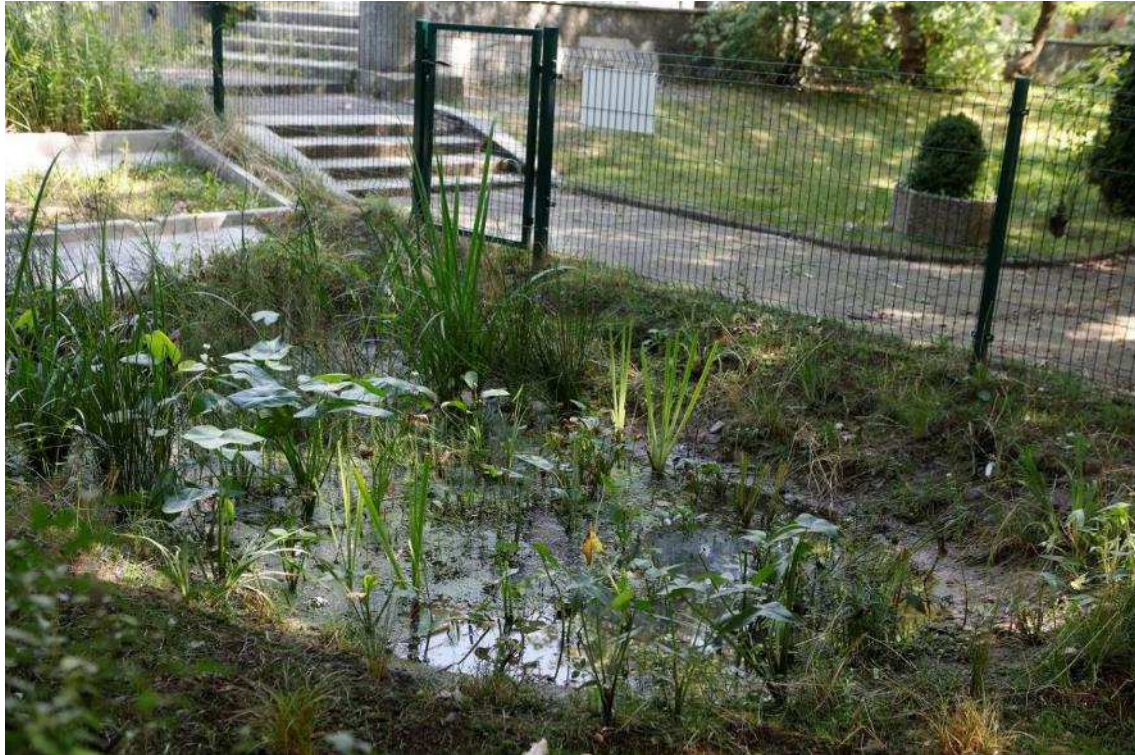
Zdjęcie21 Wygląd terenu po wybudowaniu – Ogród deszczowy
