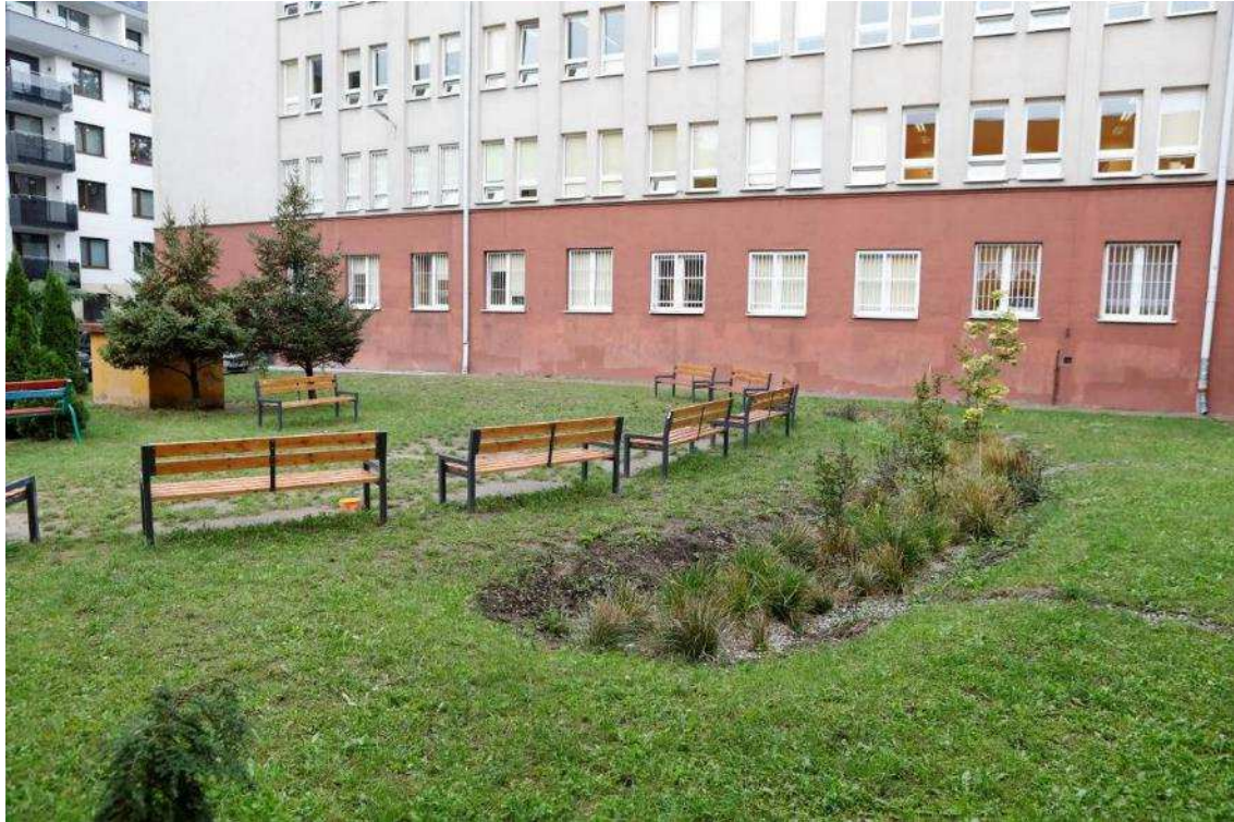
Zdjęcie 8 Stan terenu po Wykonaniu robót - Niecka chłonna ze szpalerem drzew + elementy małej architektury
