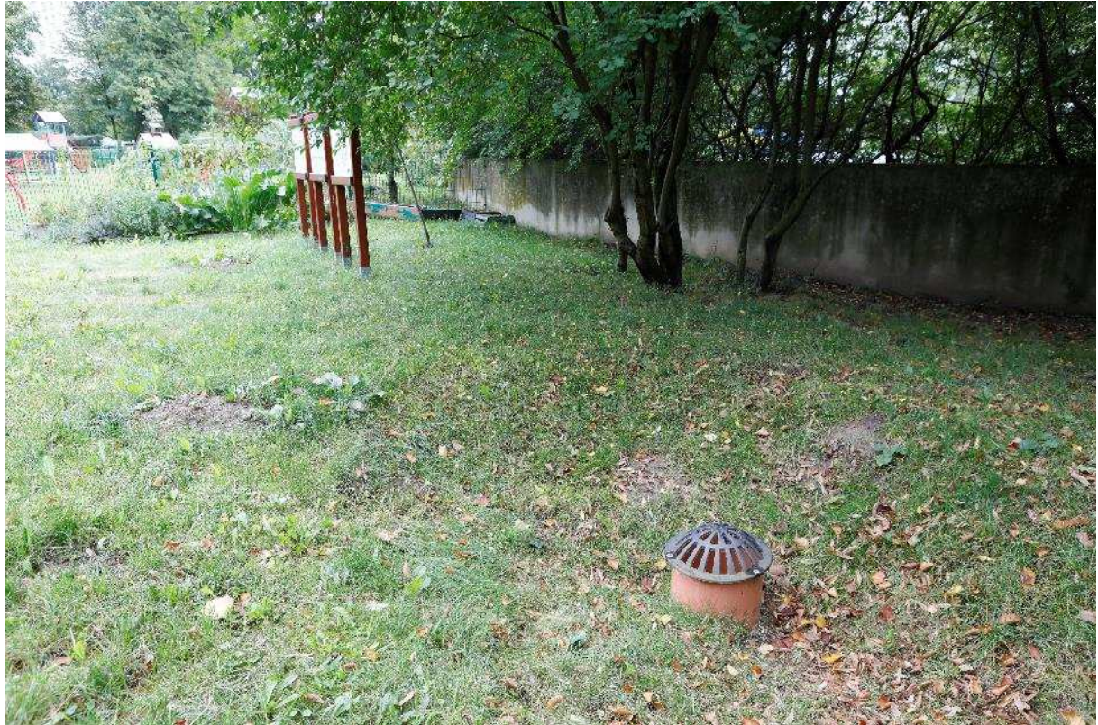
Zdjęcie 3 Wygląd miejsca po zakończeniu prac - Niecka chłonna
