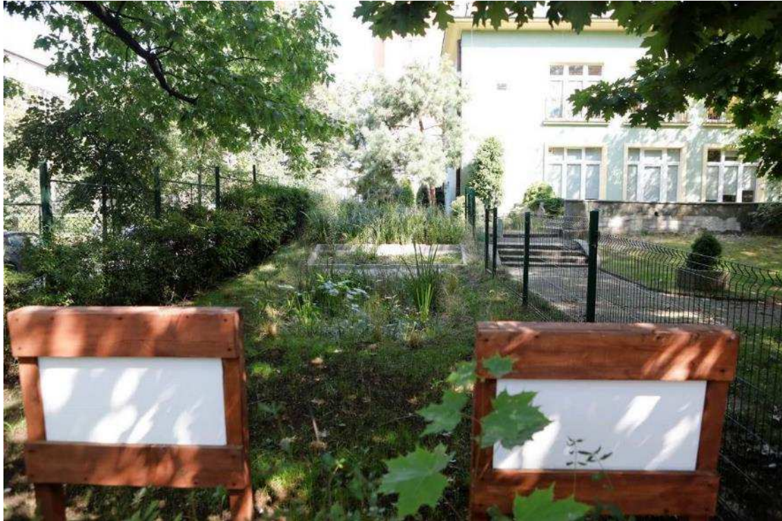
Zdjęcie 25 Teren po budowie – tablice informacyjne
