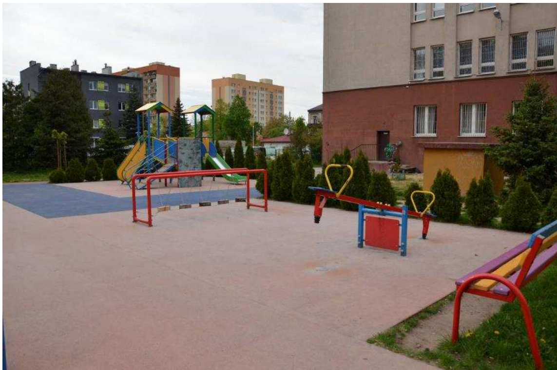
Zdjęcie 31 Stan terenu przed Wykonaniem robót -Niecka ze szpalerem drzew
