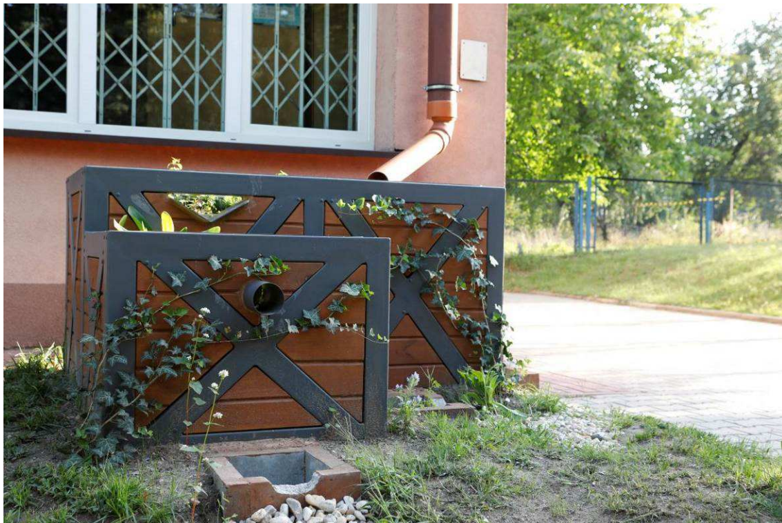
Zdjęcie 10 Stan terenu po Wykonaniu robót - Climabox + niecka
