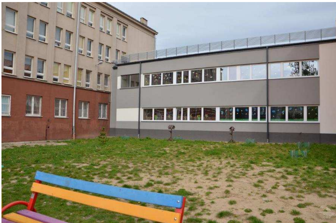
Zdjęcie 29 Stan terenu przed Wykonaniem robót -Niecka ze szpalerem drzew
