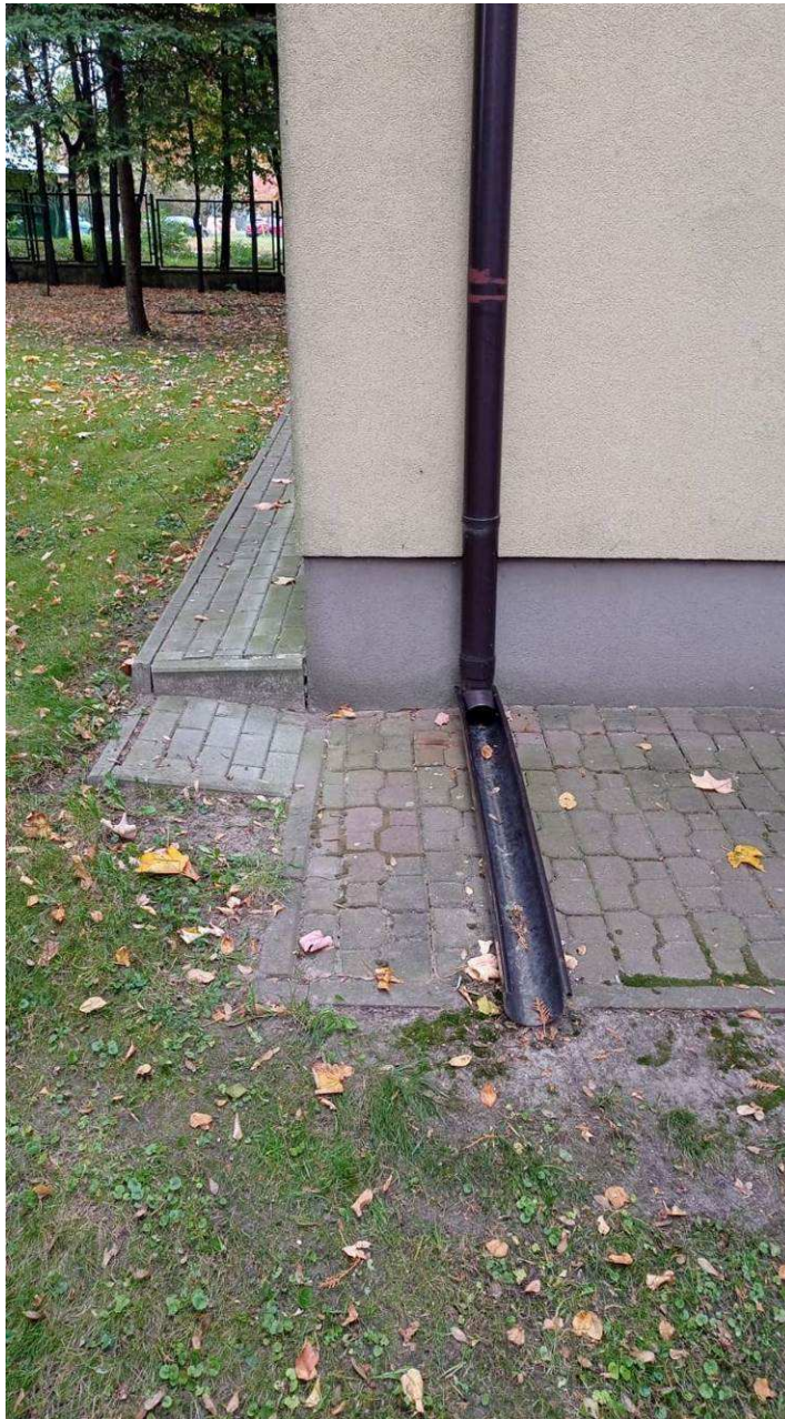
Zdjęcie 41 Stan terenu przed Wykonaniem robót - Niecka Chłonna
