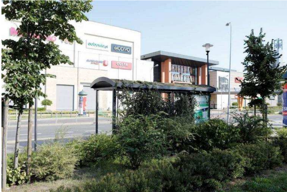
Zdjęcie 341 Stan terenu po wykonaniu robót – Ogród deszczowy w niecce za wiatką
