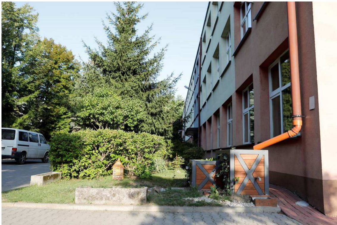
Zdjęcie 7 Stan terenu po Wykonaniu robót - Climabox + niecka
