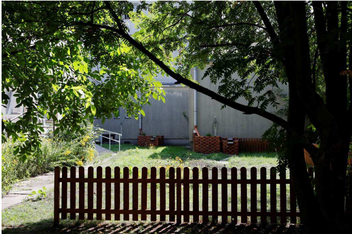
Zdjęcie 7 Stan terenu po Wykonaniu robót - Niecka chłonna
