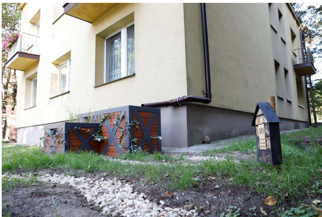
Zdjęcie 8 Stan terenu po Wykonaniu robót - Niecka chłonna - doprowadzenie wody suchym strumieniem
