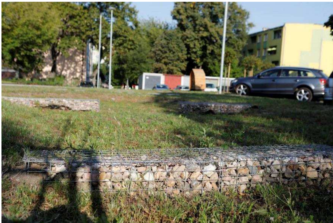
Zdjęcie 6 Stan terenu po Wykonaniu robót - Niecki chłonne - gabiony
