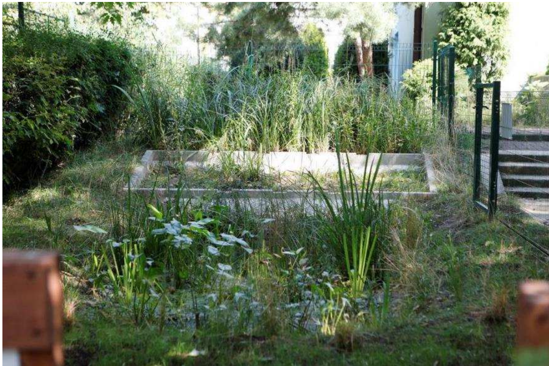
Zdjęcie24 Wygląd terenu po wybudowaniu – Ogród deszczowy
