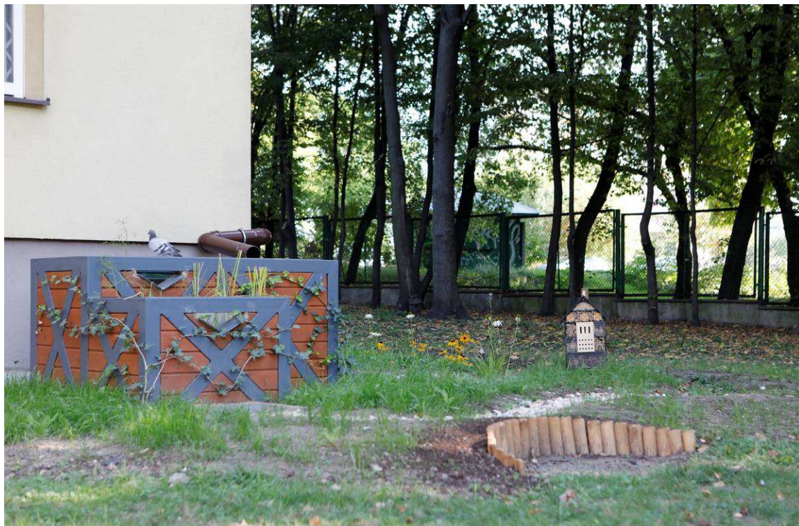
Zdjęcie 5 Stan terenu po Wykonaniu robót - Niecka chłonna
