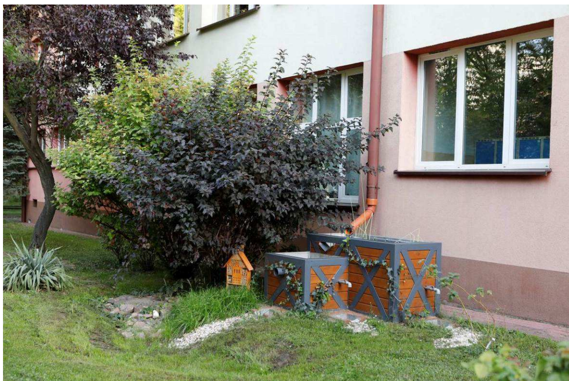
Zdjęcie 2 Stan terenu po Wykonaniu robót - Climabox + niecka
