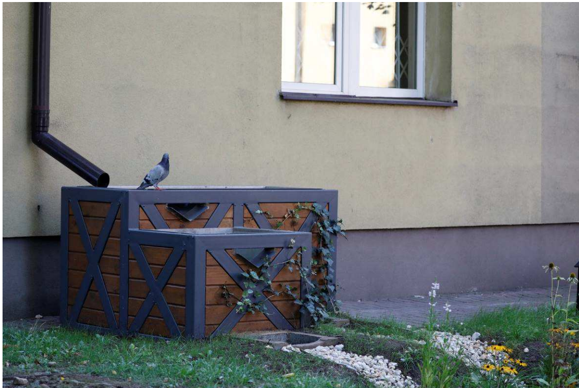
Zdjęcie 18 Stan terenu po Wykonaniu robót - Niecka chłonna
