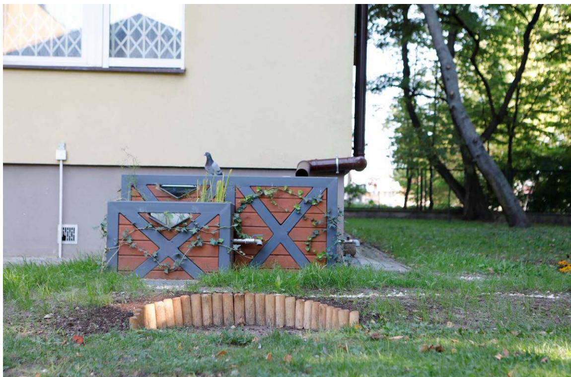
Zdjęcie 6 Stan terenu po Wykonaniu robót - Niecka chłonna
