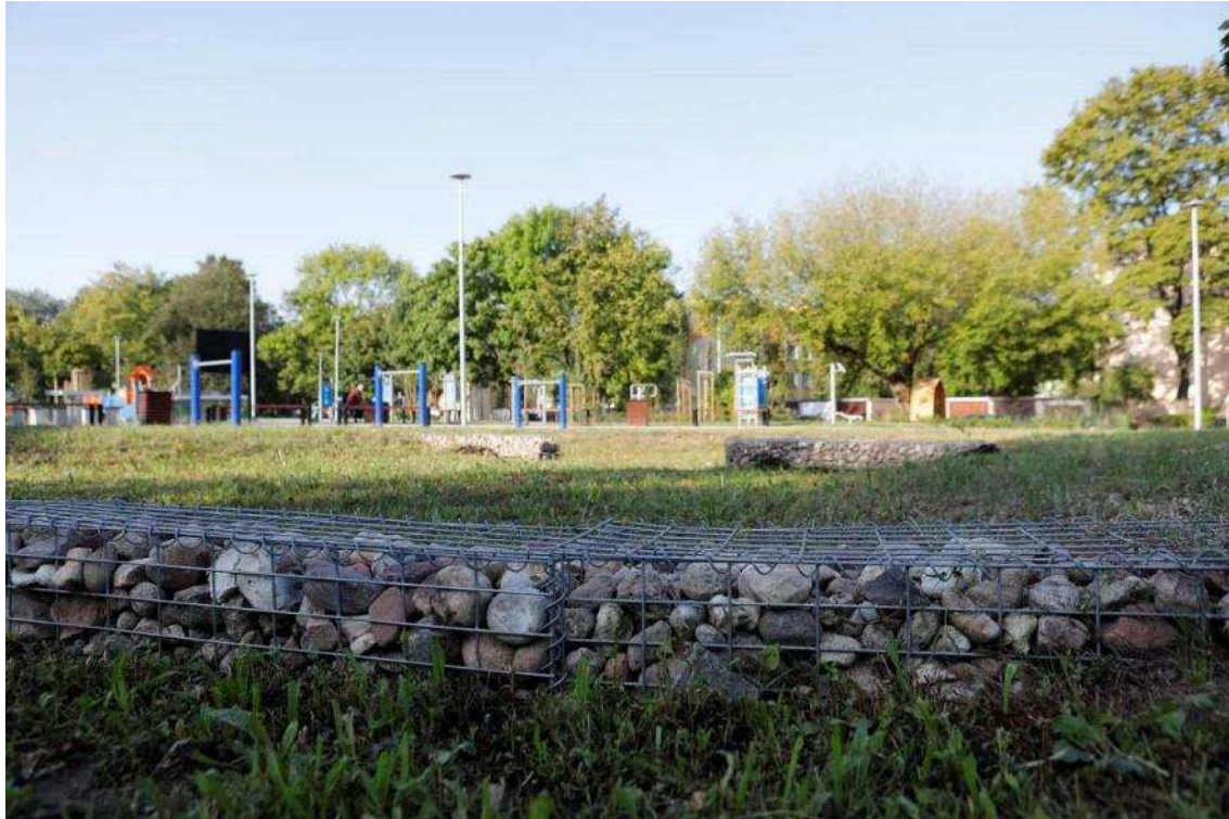
Zdjęcie 7 Stan terenu po Wykonaniu robót - Niecki chłonne - gabiony
