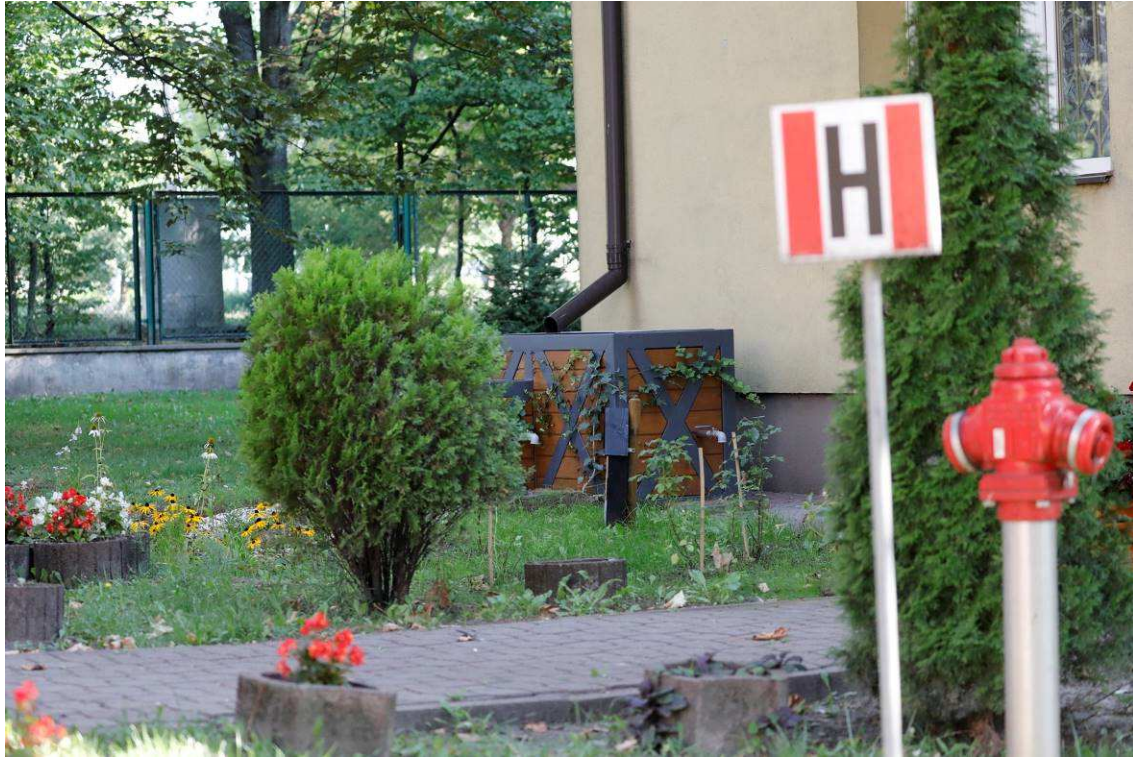
Zdjęcie 17 Stan terenu po Wykonaniu robót - Niecka chłonna
