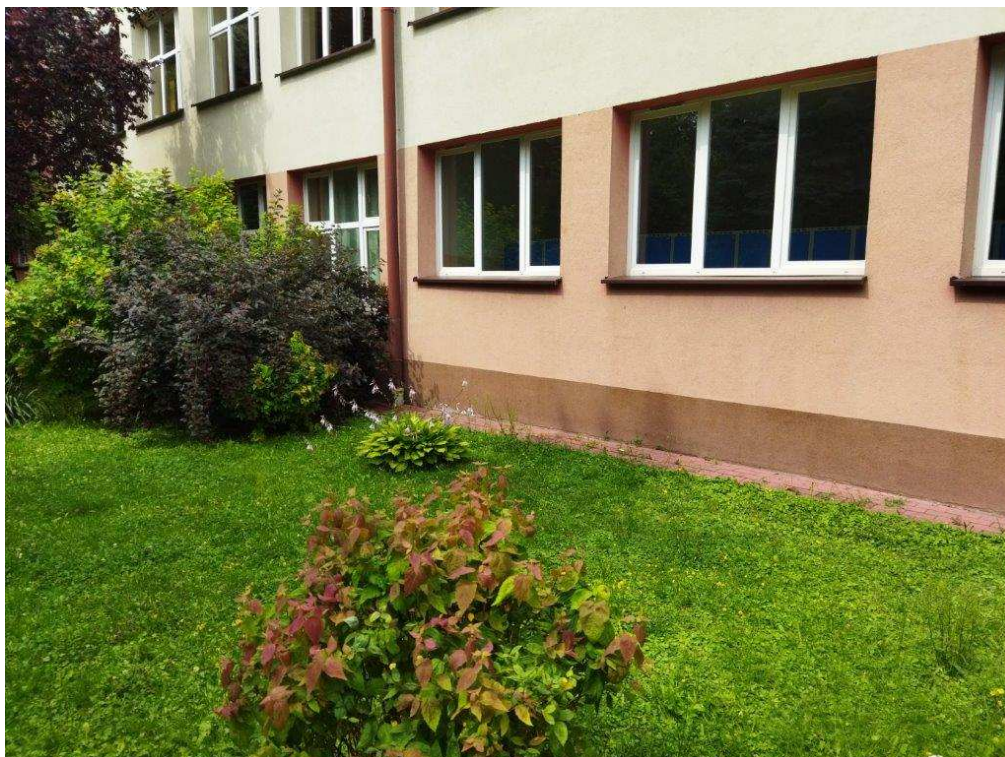
Zdjęcie 45 Stan terenu przed wykonaniem robót - Niecka chłonna
