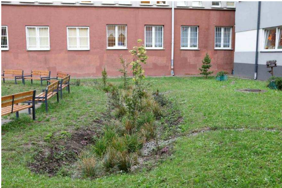
Zdjęcie 9 Stan terenu po Wykonaniu robót - Niecka chłonna ze szpalerem drzew + elementy małej architektury
