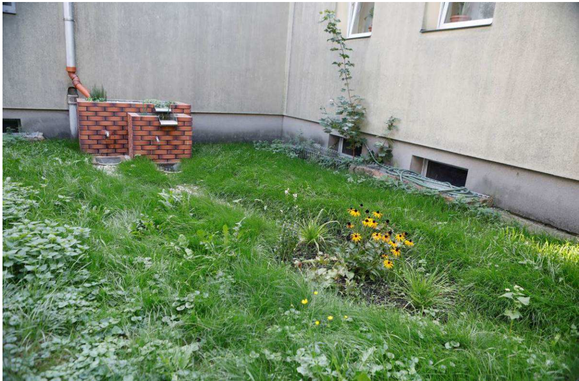
Zdjęcie 40 Stan terenu po Wykonaniu robót - Niecka chłonna
