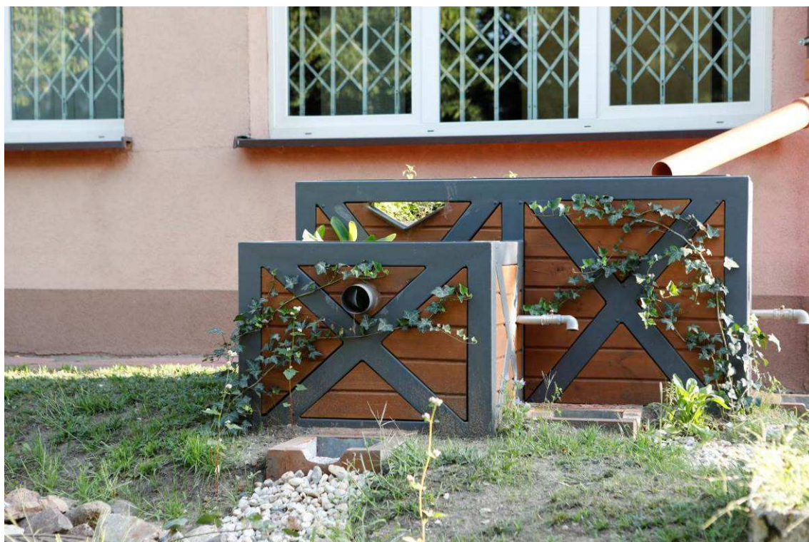
Zdjęcie 4 Stan terenu po Wykonaniu robót - Climabox + niecka
