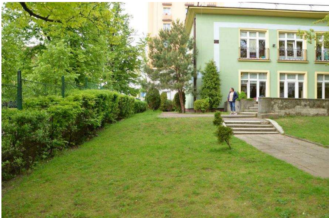
Zdjęcie 2 - Teren przed budową
