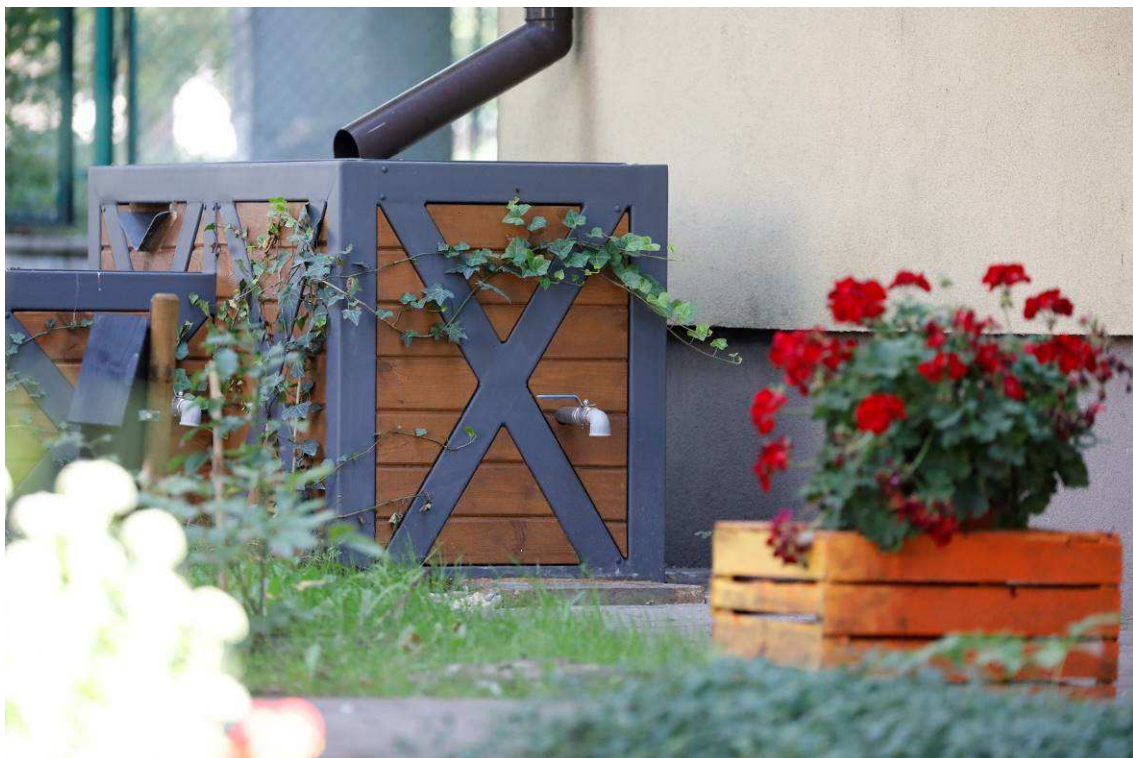
Zdjęcie 16 Stan terenu po Wykonaniu robót - Niecka chłonna
