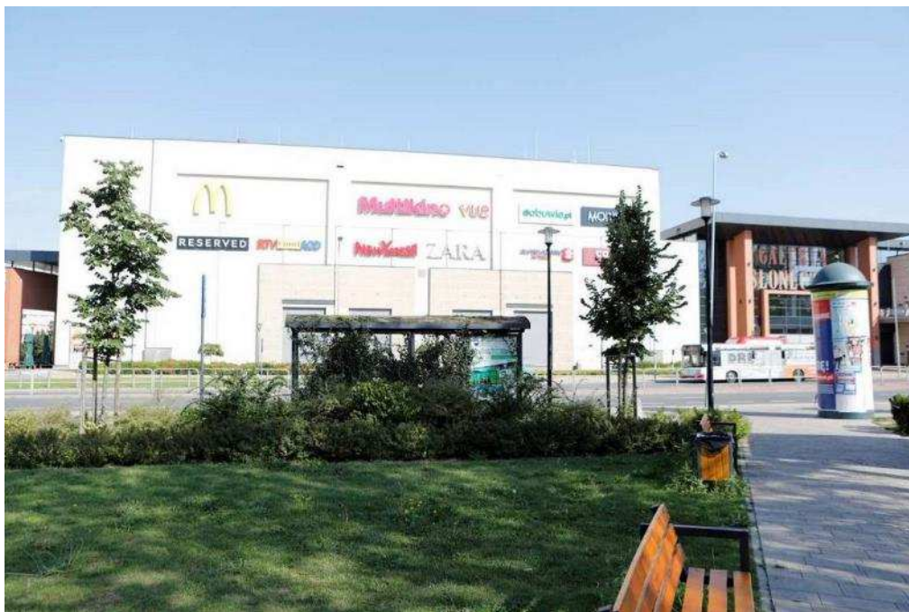
Zdjęcie 330 Stan terenu po wykonaniu robót – Ogród deszczowy w niecce za wiatką
