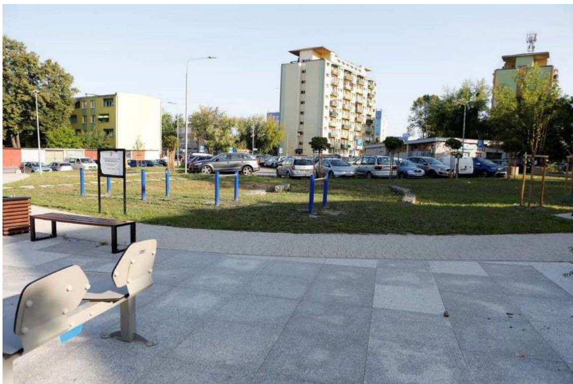
Zdjęcie 12 Stan terenu po Wykonaniu robót - Niecki chłonne -elementy małej architektury
