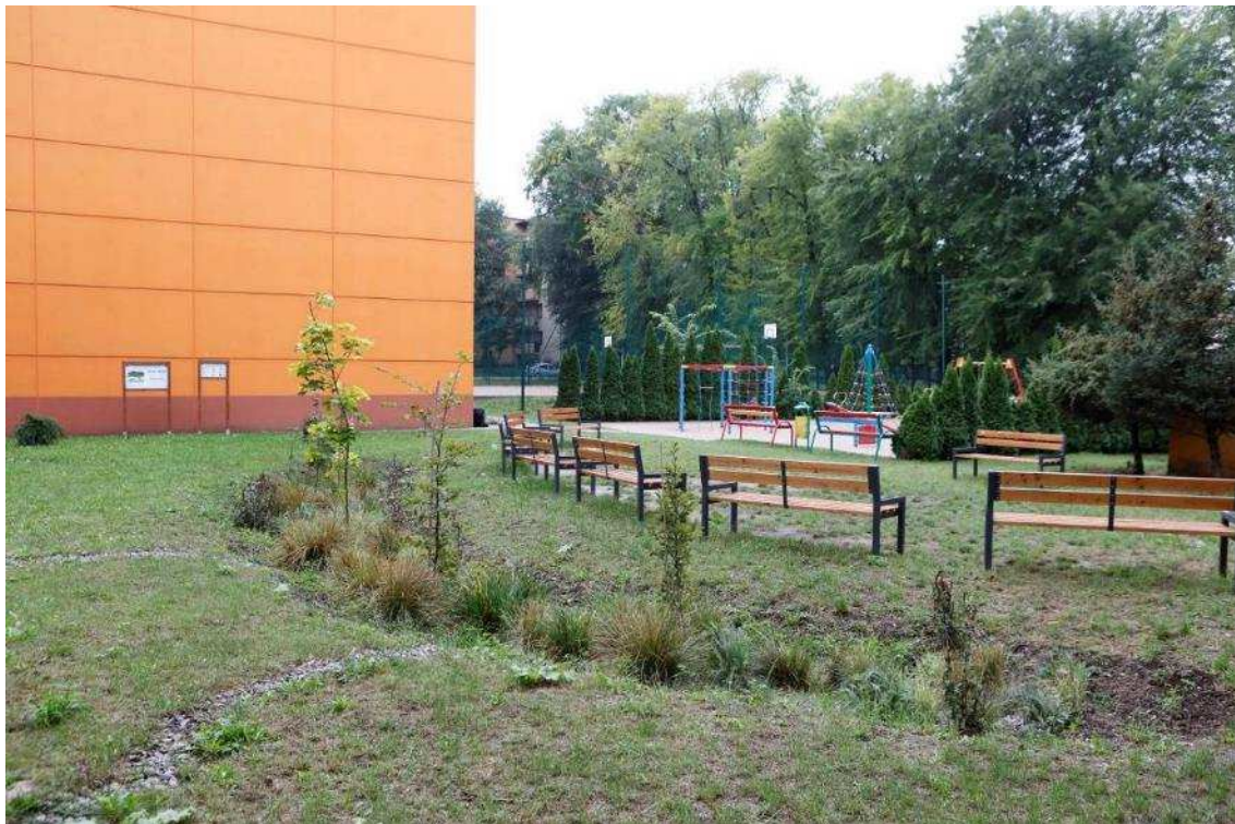
Zdjęcie 11 Stan terenu po Wykonaniu robót - Niecka chłonna ze szpalerem drzew + elementy małej architektury
