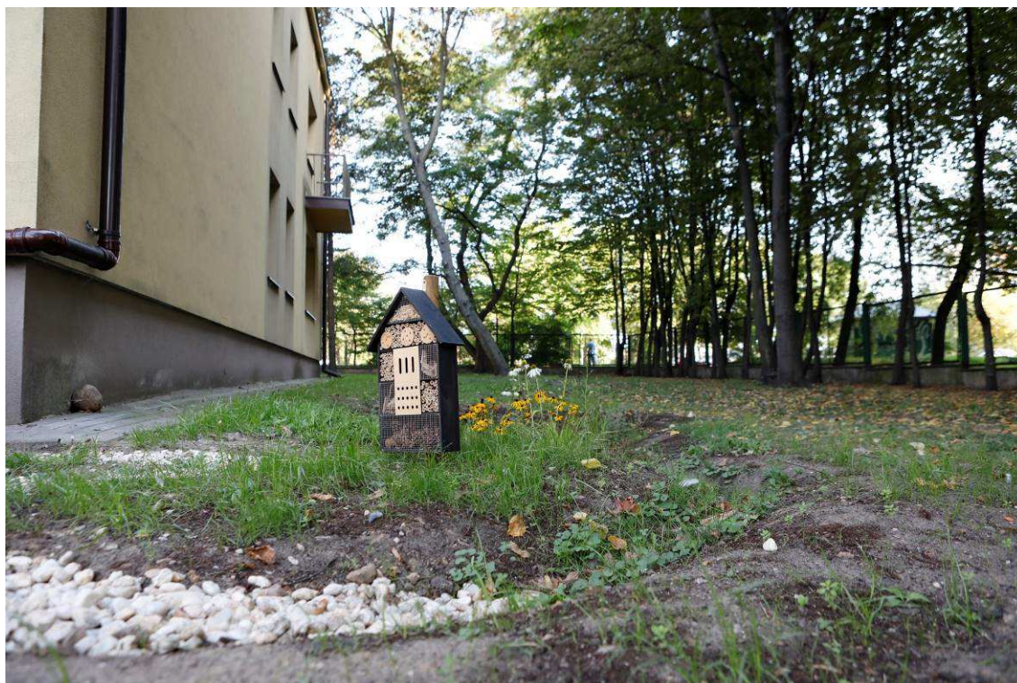
Zdjęcie 7 Stan terenu po Wykonaniu robót - Niecka chłonna + domek dla owadów
