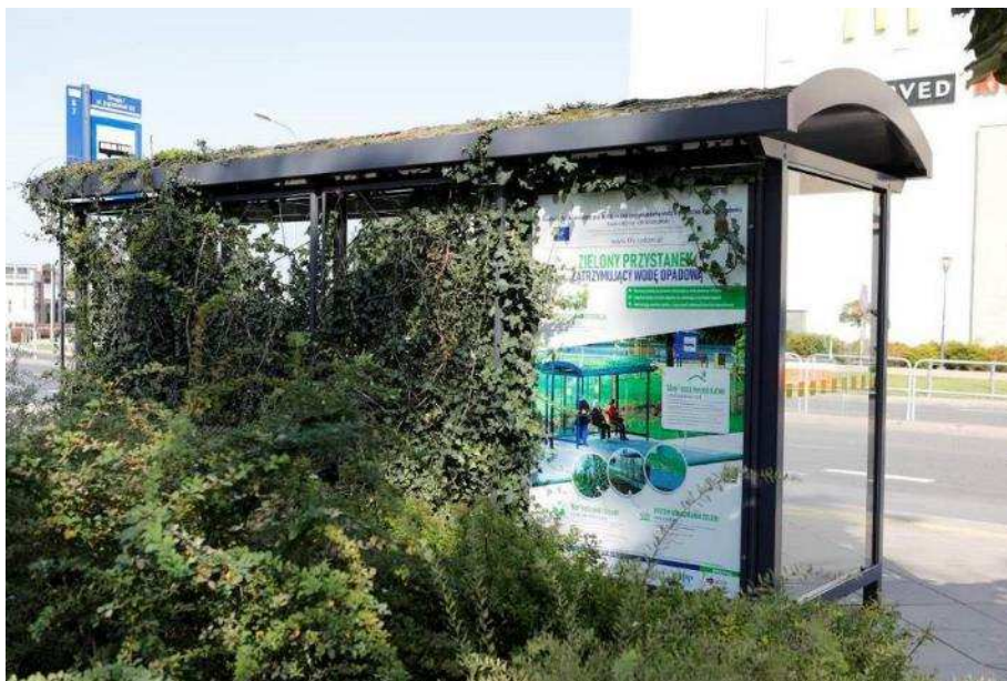
Zdjęcie 352 Stan terenu po wykonaniu robót – Ogród deszczowy w niecce za wiatką
