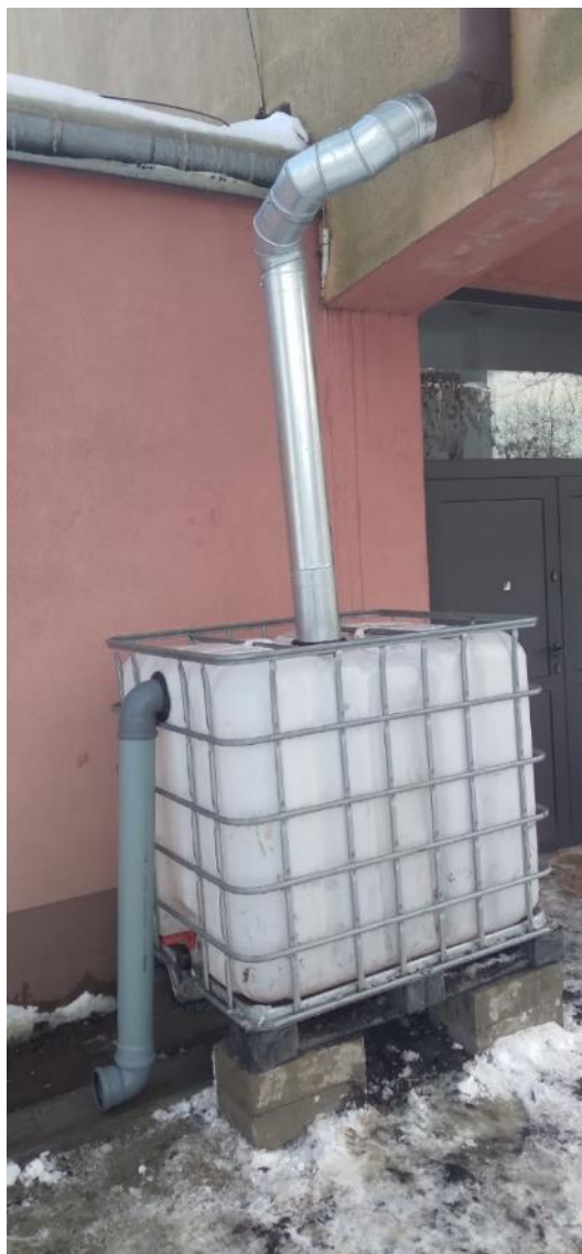
Zdjęcie 5 Wygląd terenu po zakończeniu budowy – zbiornik na deszczówkę
