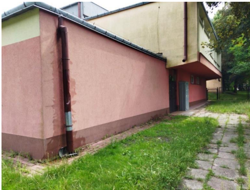
Zdjęcie 1 Wygląd terenu przed budową - Zbiornik na deszczówkę i Powierzchnia przepuszczalna
