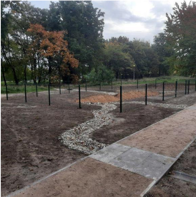
Zdjęcie 8 Wygląd terenu po zakończeniu budowy – Powierzchnia przepuszczalna
