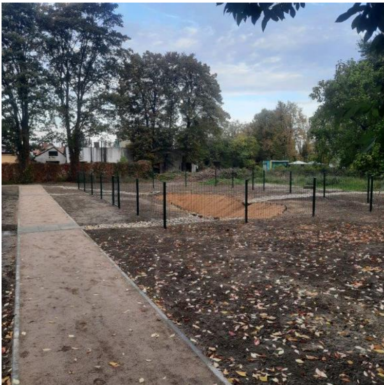
Zdjęcie 9 Wygląd terenu po zakończeniu budowy – Powierzchnia przepuszczalna
