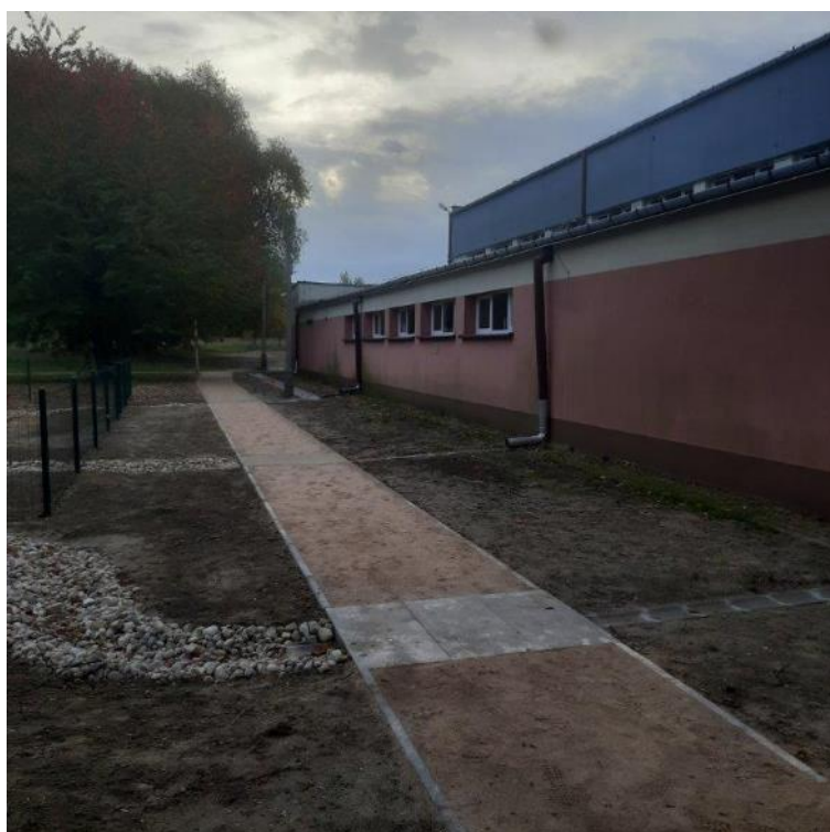
Zdjęcie 7 Wygląd terenu po zakończeniu budowy – Powierzchnia przepuszczalna
