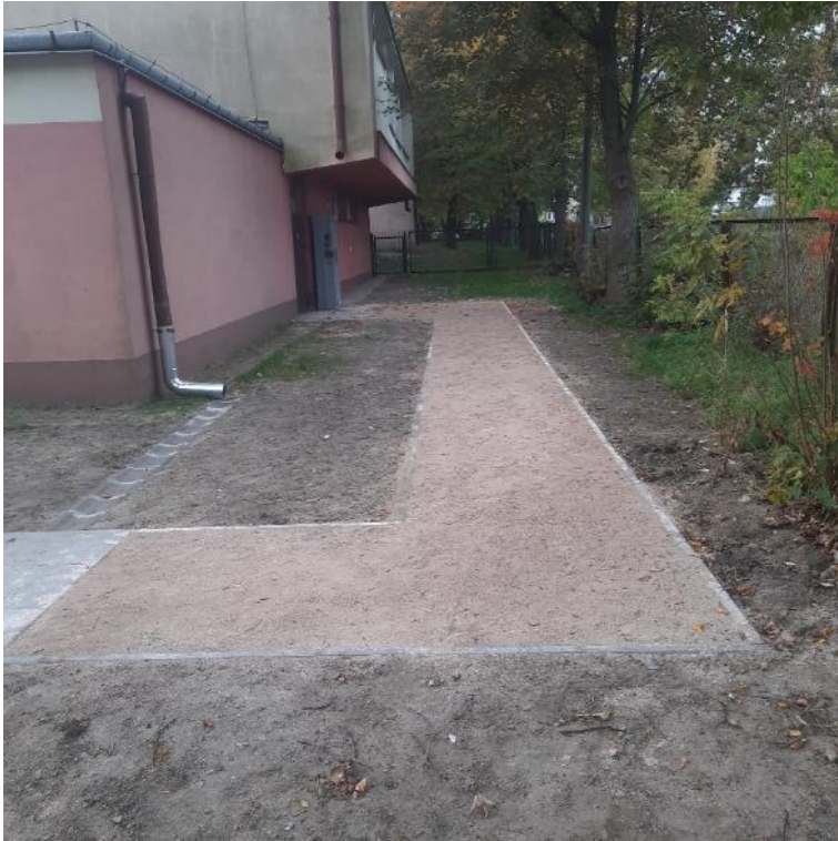
Zdjęcie 10 Wygląd terenu po zakończeniu budowy – Powierzchnia przepuszczalna
