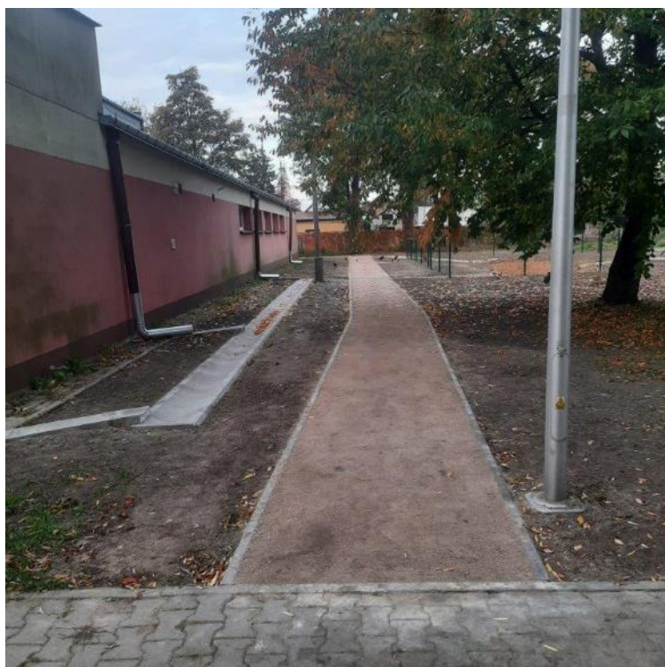
Zdjęcie 6 Wygląd terenu po zakończeniu budowy – Powierzchnia przepuszczalna
