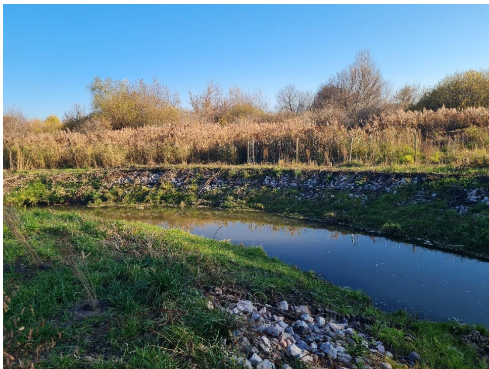
Fot.4. Fragment brzegu meandra umocnionego gabionem i kiską faszynową (fot. K. Kwiatkowska 2022).
