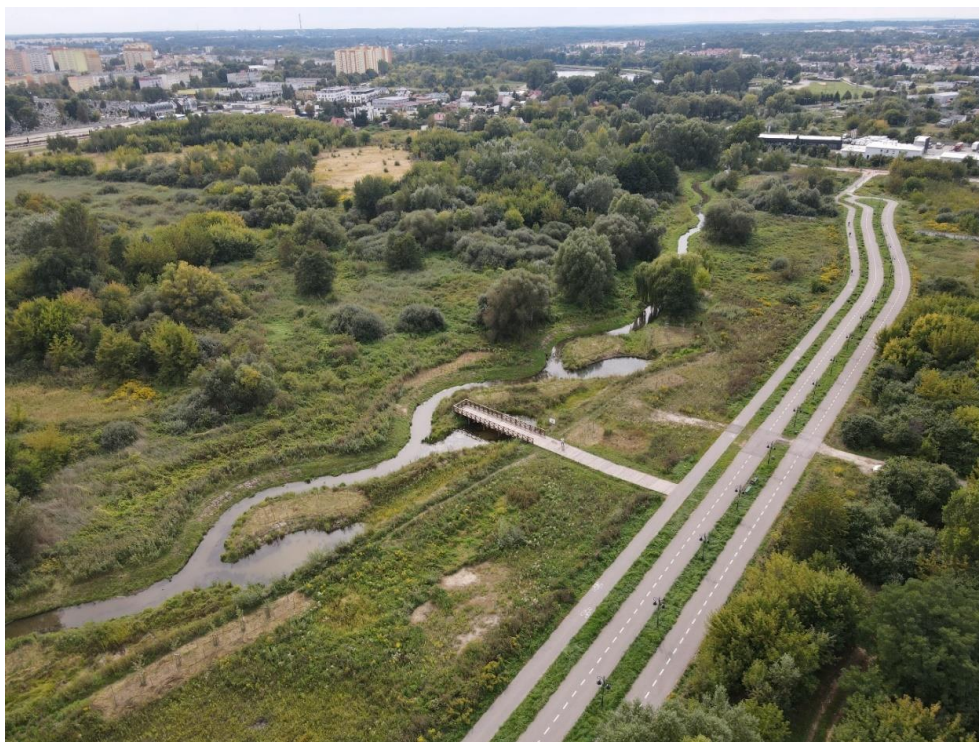
Fot.1. Odcinek Mlecznej po wykonanych modyfikacjach hydrotechnicznych (fot. Sebastian Szklarek 2022).
