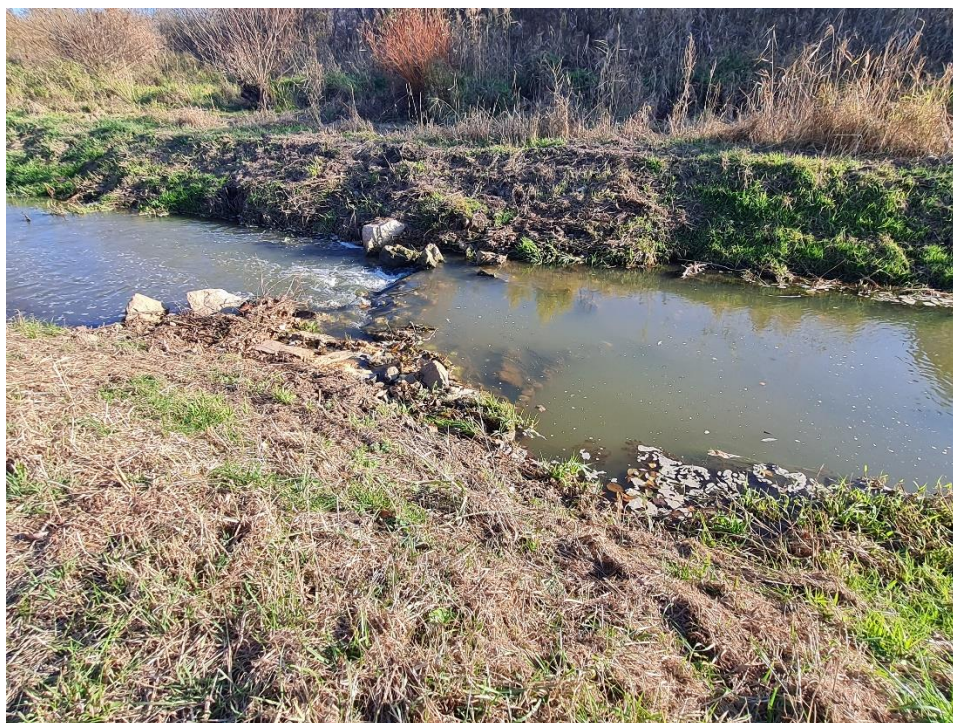
Fot.3. Deflektor w pierwszym profilu badawczym – strefa przepływu gładkiego przed progiem i wartkiego za progiem (fot. K. Kwiatkowska 2022).
