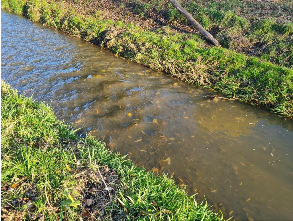
Fot.6. Strefa wartkiej wody nad rampą z narzutu kamiennego (fot. K. Kwiatkowska 2022).
