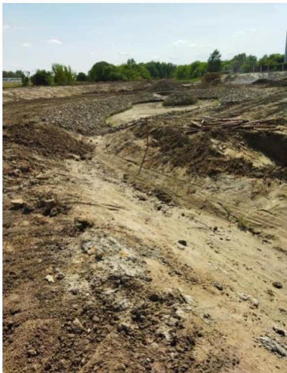
Potok Północny – budowa (maj 2022)
