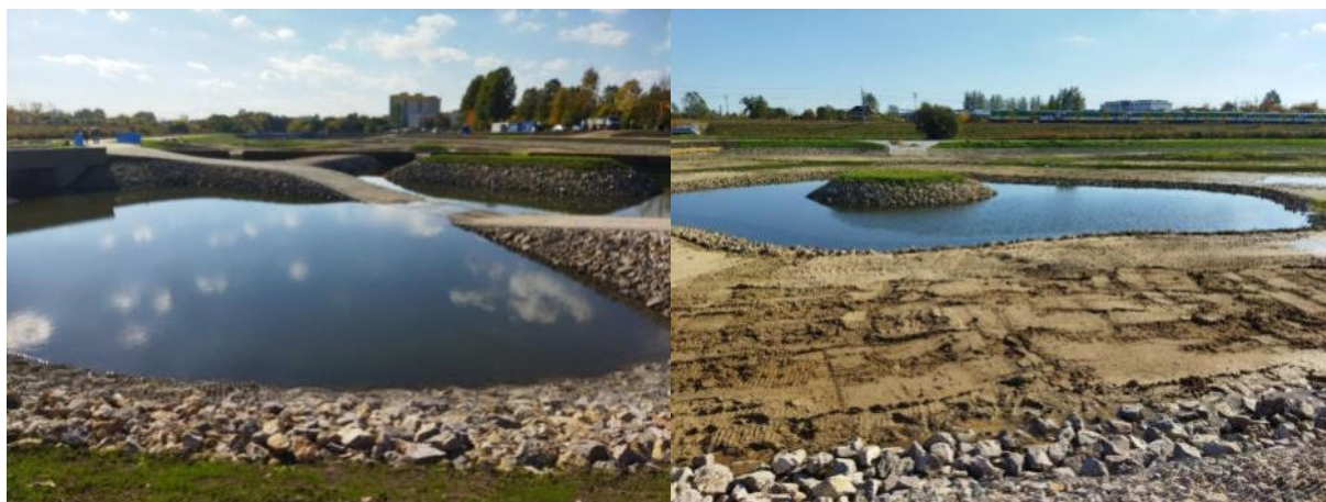
FOT. 3 – POTOK PÓŁNOCNY PO BUDOWIE (WIOSNA 2022)
