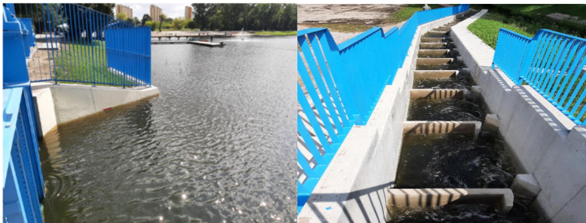
FOT.2 – ZBIORNIK BORKI I PRZEPLAWKA NA JAZIE ZBIORNIKA
