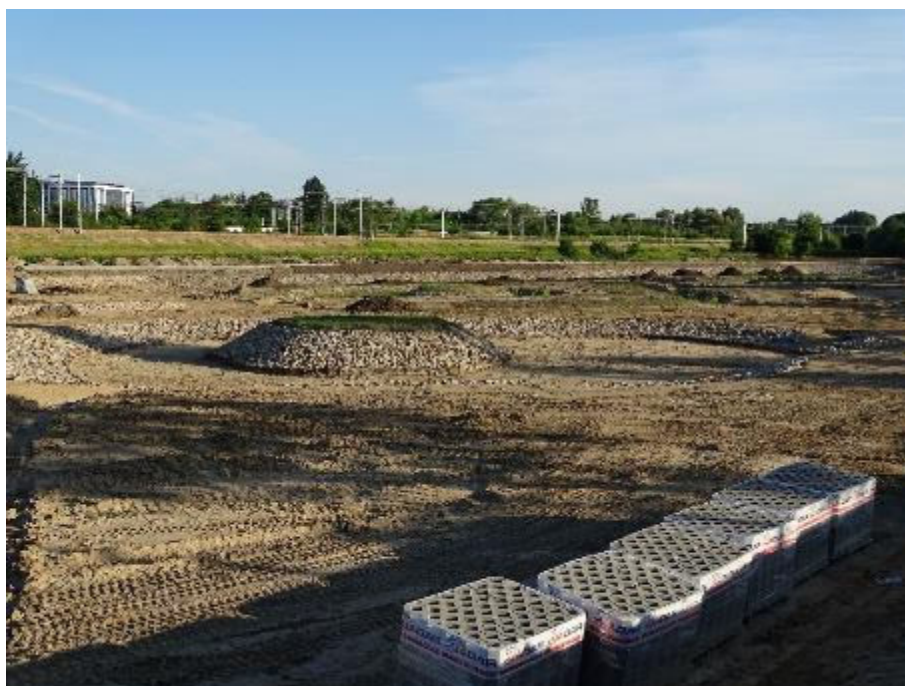
Zdj. 14. Potok Północny – budowa zbiornika w centralnej części obiektu (25.06.2022)
