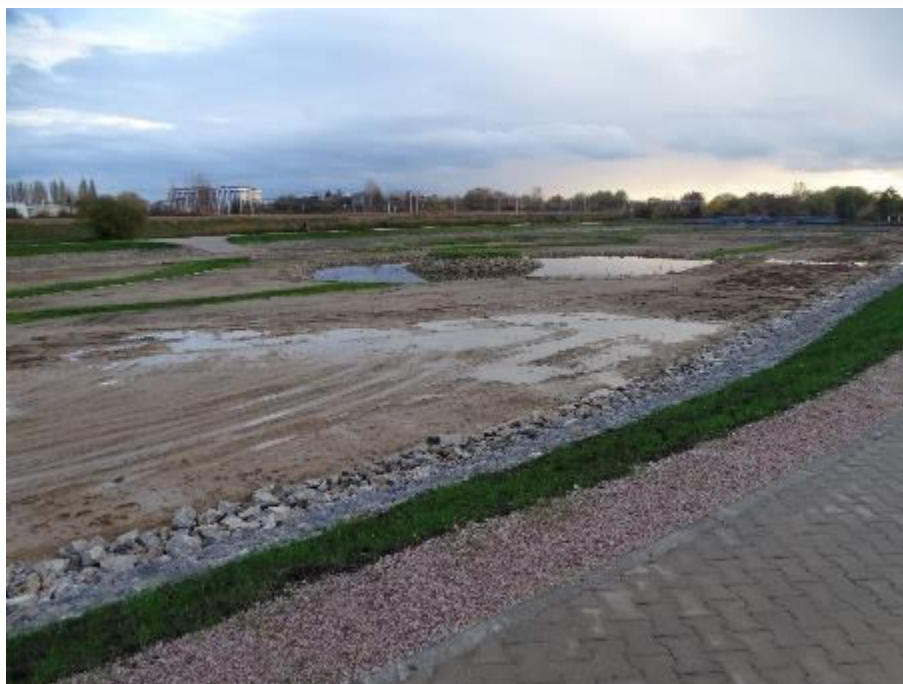
Zdj. 15. Potok Północny – oddany jesienią zbiornik wielofunkcyjny (25.10.2022)
