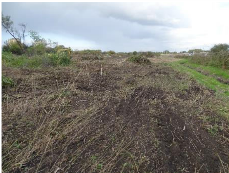
Zdj. 13. Potok Północny – prace inwestycyjne w centralnej części obiektu (13.10.2021)
