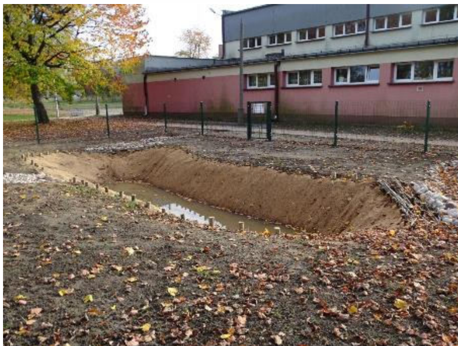
Zdj. 57. XI Liceum Ogólnokształcące im. Stanisława Staszica – oczko wodne, w trakcie budowy (25.10.2022)
