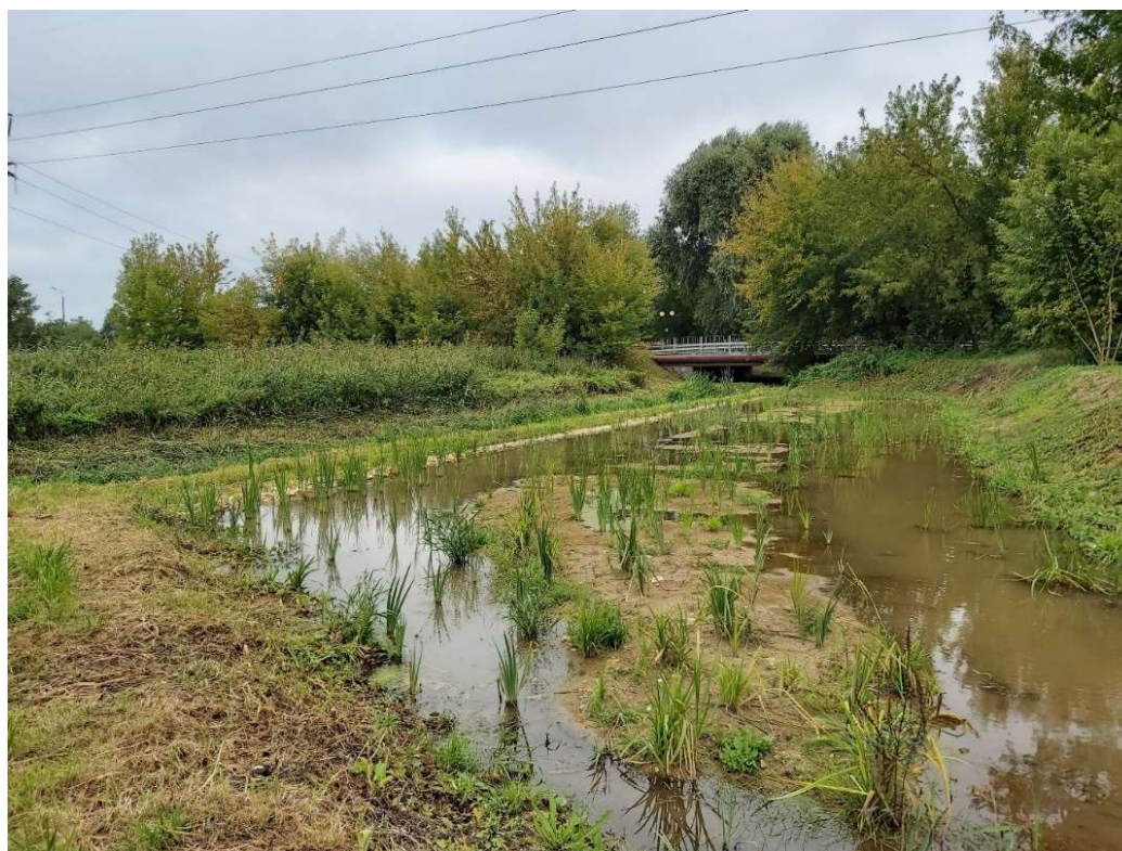
Zdjęcie 12. Część biofiltracyjna systemu. Zdjęcie wykonano dnia 19 września 2022 r., godz. 08:45.
