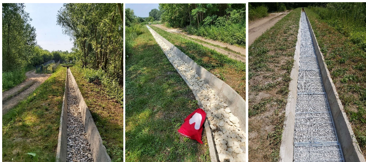
Zdjęcia 7, 8 i 9. Widok na poszczególne bariery filtracyjne (PBR). Od lewej: bariera dolomitowa, wapienna i wypełniona preparatem BioKer w formie stalowych koszy.
