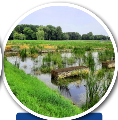
Adaptacja stawów kolmatacyjnych
