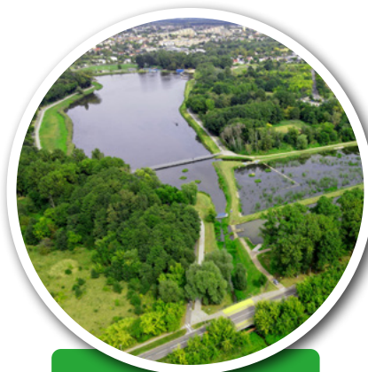
Adaptacja zbiornika Borki
