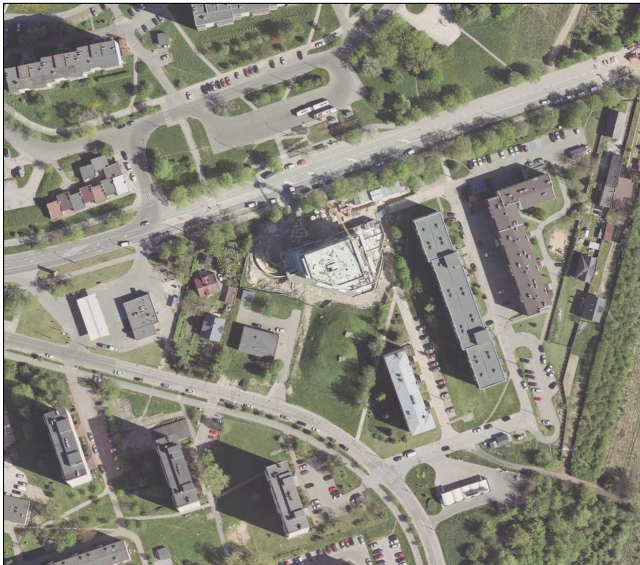
Zdjęcie 2 Zagospodarowanie terenu hydroforni osiedlowej „Nad Potokiem” (ST2 „Olsztyńska”)
