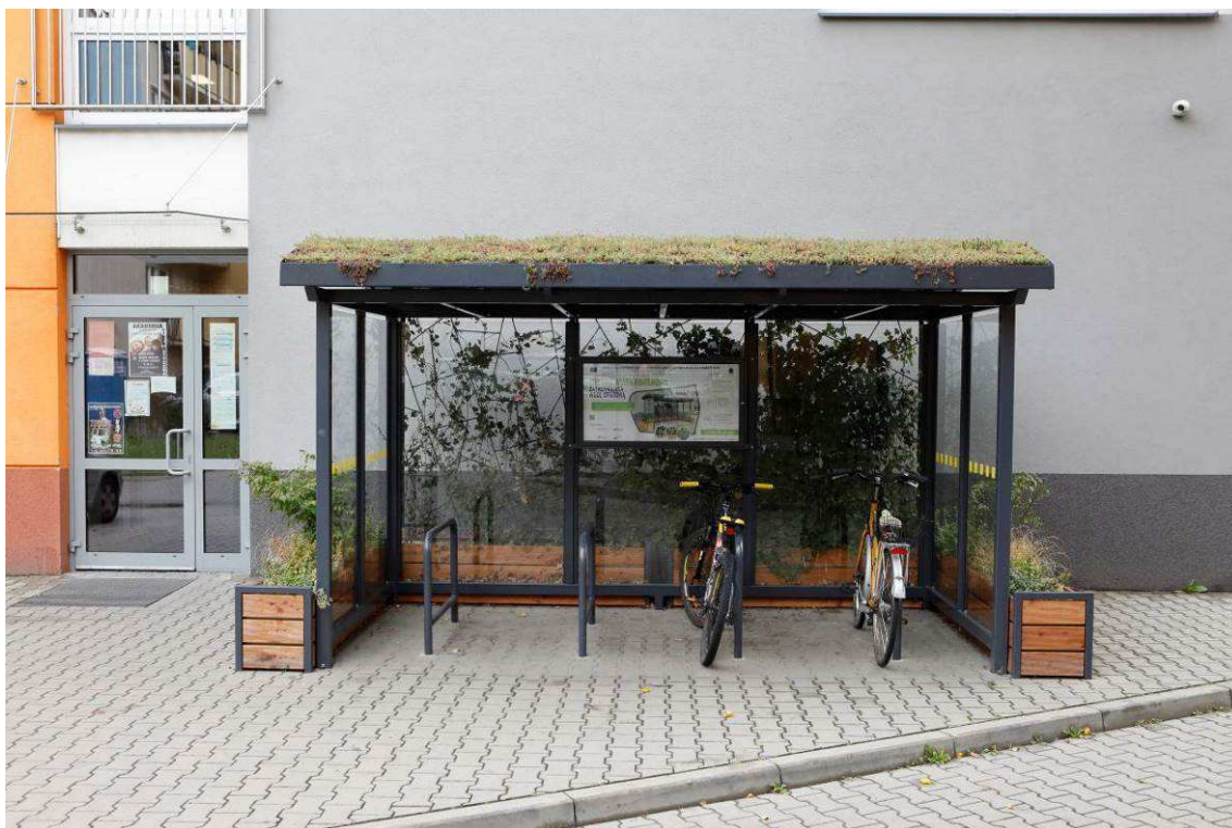
Fotografia 11 Stan terenu po Wykonaniu robót – Zielona Wiata Rowerowa - Zielony Dach + Donice na nasadzenia
