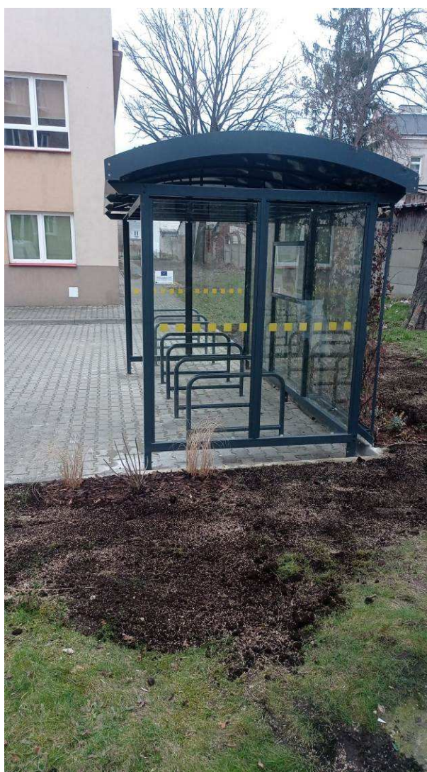
Fotografia 6 Stan terenu po zakończeniu robót - zielona wiata rowerowa z nasadzeniami roślinności
