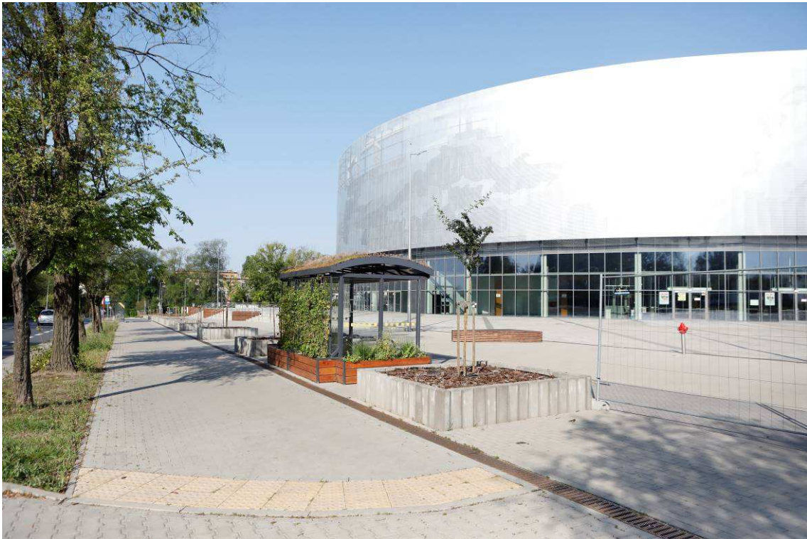
Fotografia 5 Stan terenu po Wykonaniu robót – Zielona Wiata Rowerowa
