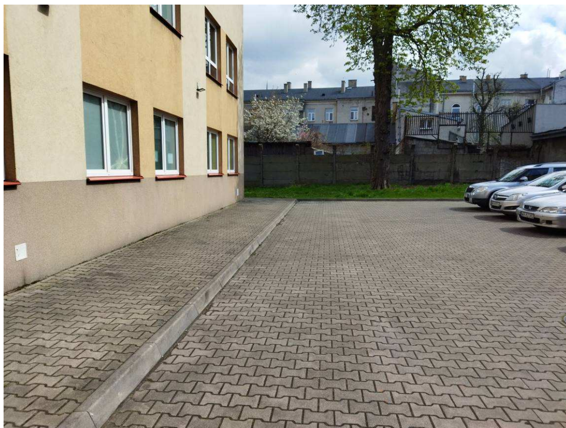
Fotografia 1 Stan terenu przed Wykonaniem robót – Zielona Wiata Rowerowa
