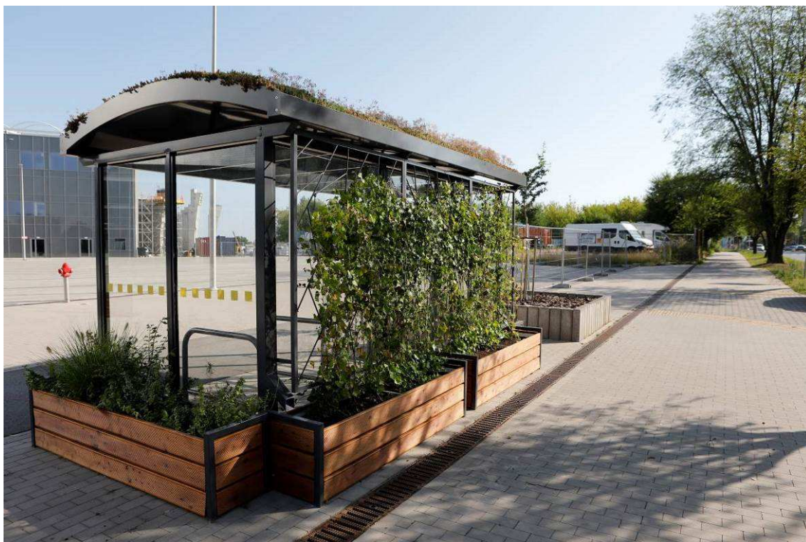
Fotografia 9 Stan terenu po Wykonaniu robót – Zielona Wiata Rowerowa –Donice + Zielona Ściana
