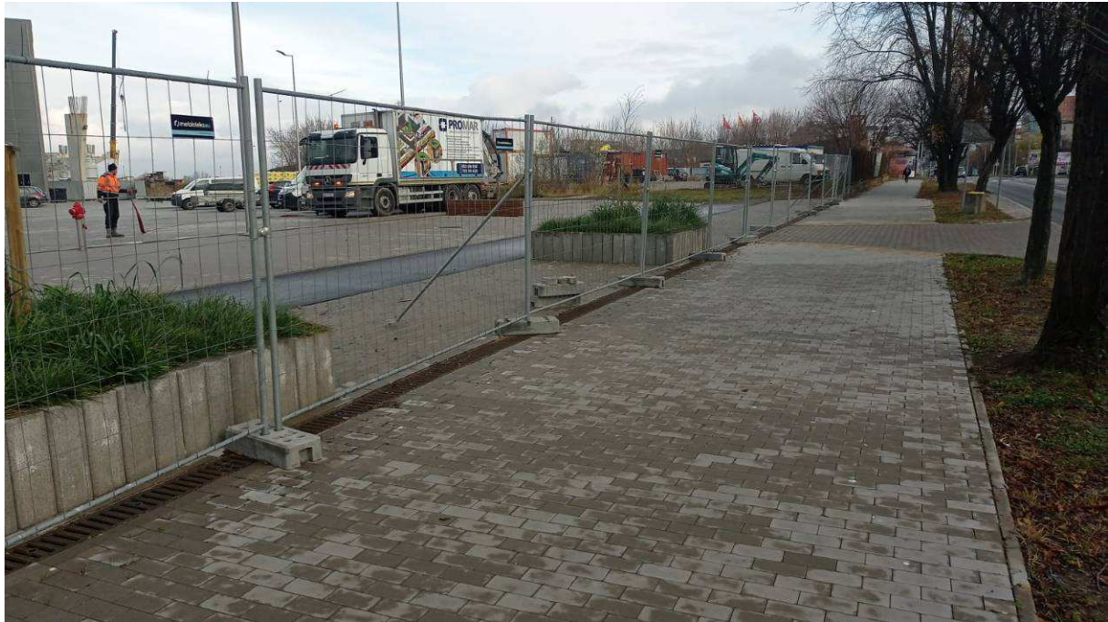
Fotografia 4 Stan terenu przed Wykonaniem robót - Zielona Wiata Rowerowa
