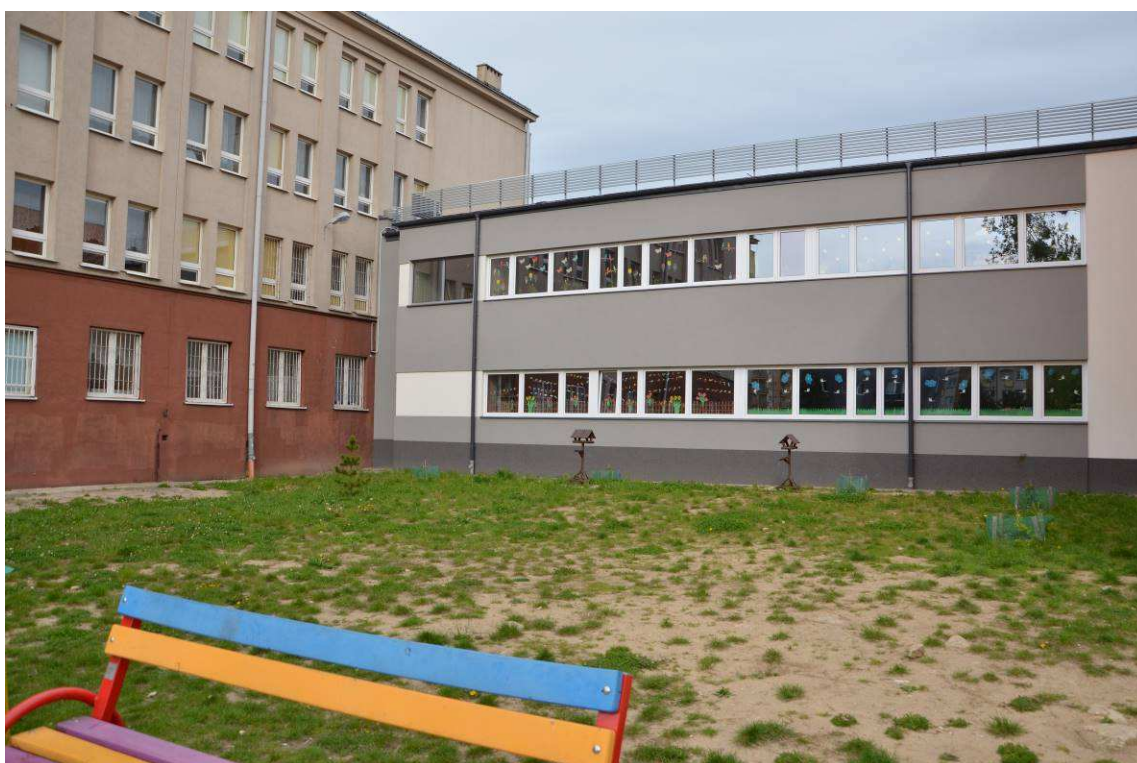
Fotografia 2 Stan terenu przed Wykonaniem robót -Niecka ze szpalerem drzew
