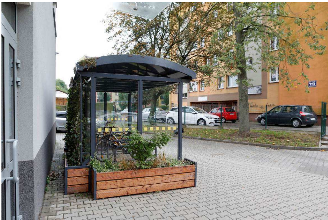
Fotografia 10 Stan terenu po Wykonaniu robót – Zielona Wiata Rowerowa - Zielona Ściana + Donice na nasadzenia
