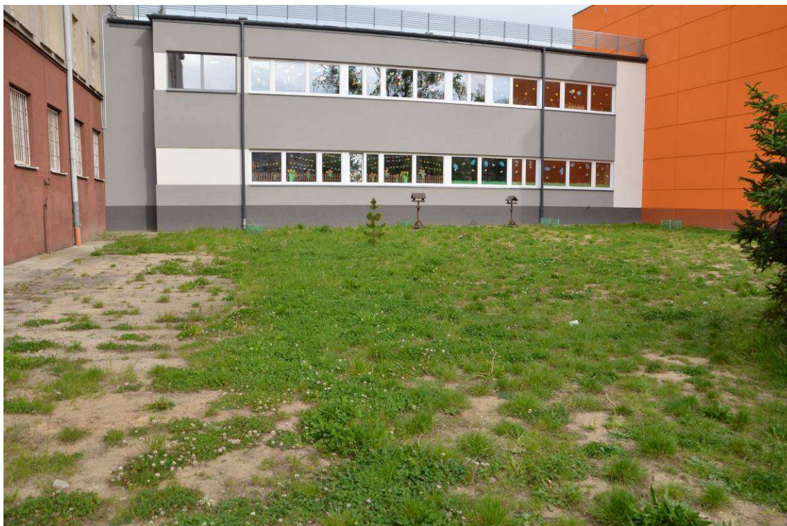
Fotografia 1 Stan terenu przed Wykonaniem robót -Niecka ze szpalerem drzew
