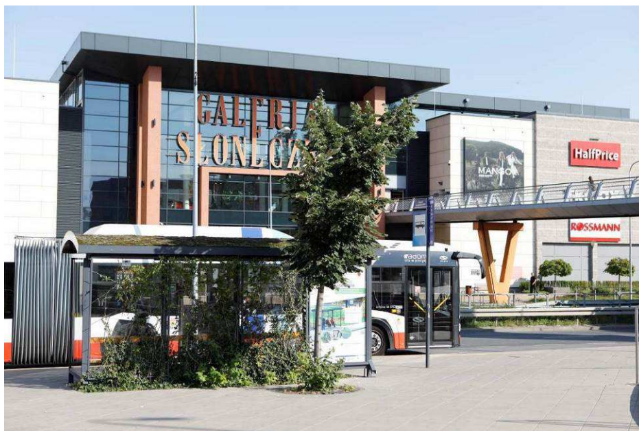
Fotografia 1 Stan terenu po wykonaniu robót – Zielona Wiata Przystankowa z Zielonym Dachem i Zieloną Ścianą
