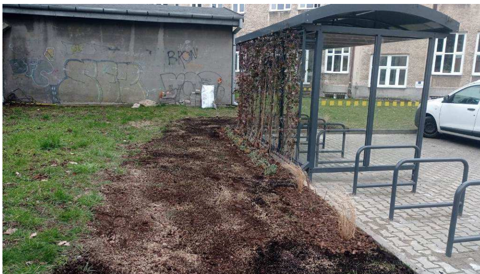
Fotografia 9 Stan terenu po zakończeniu robót - zielona wiata rowerowa z nasadzeniami roślinności
