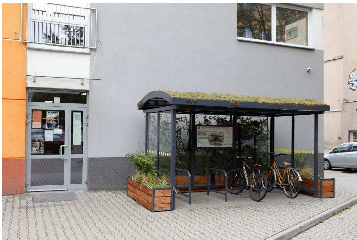
Fotografia 12 Stan terenu po Wykonaniu robót – Zielona Wiata Rowerowa - Zielony Dach + Donice na nasadzenia
