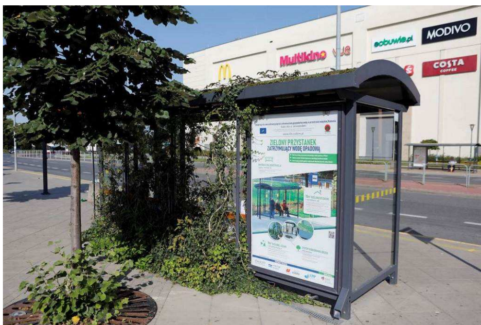
Fotografia 6 Stan terenu po Wykonaniu robót – Zielona Wiata Przystankowa z Zielonym Dachem i Zieloną Ścianą - Plakat Informacyjny
