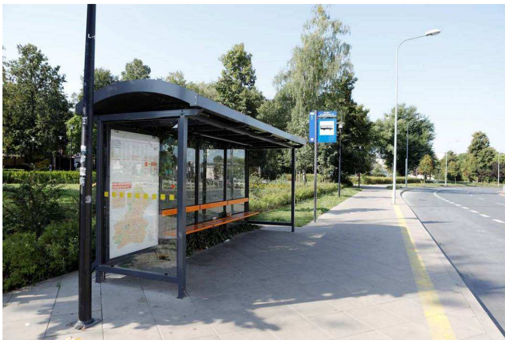
Fotografia 7 Stan terenu po Wykonaniu robót – Zielona Wiata Przystankowa z Zielonym Dachem i Zieloną Ścianą
