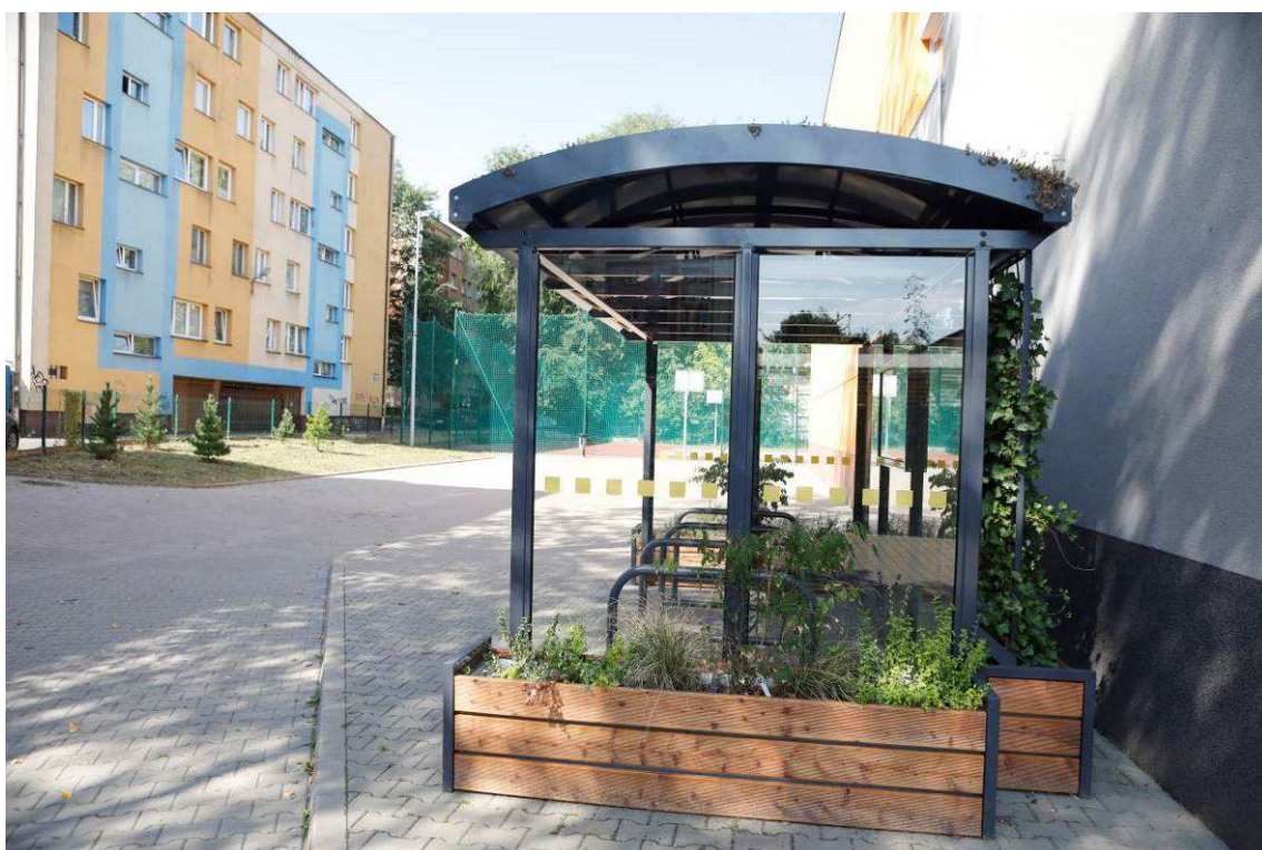
Fotografia 9 Stan terenu po Wykonaniu robót – Zielona Wiata Rowerowa - Zielona Ściana + Donice na nasadzenia
