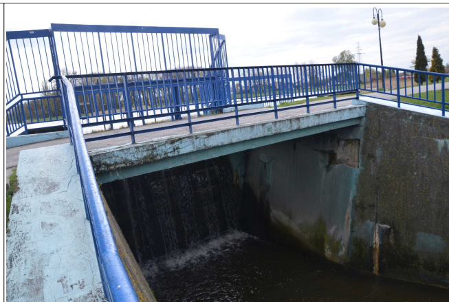
Fot.2. Jaz główny – widok od strony wody dolnej (fot. Beata Naglik).
