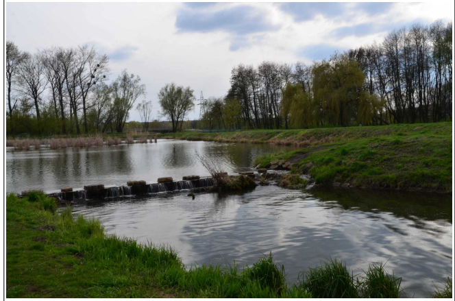
Fot.11. Próg przelewowy między stawem kolmatacyjnym dolnym, a odpływem do zbiornika Borki (w prawej części widoczne wyżłobienie w formie bystrotoku – naturalna „przeplawka”) (fot. Beata Naglik).
