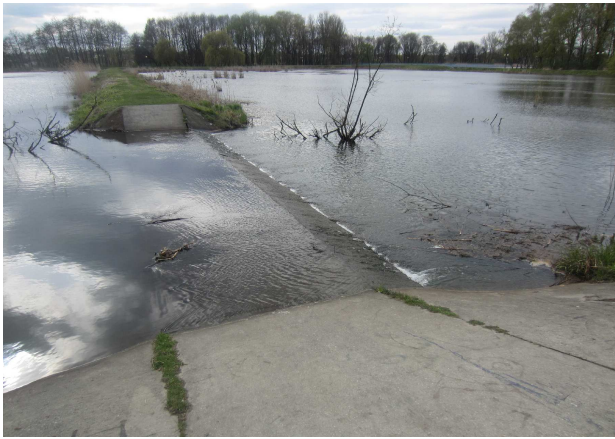
Fot.10. Próg przelewowy między stawem kolmatacyjnym górnym a dolnym (fot. Beata Naglik).
